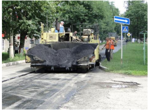
Укладка асфальта. ул. л. Толстого, д. 46
