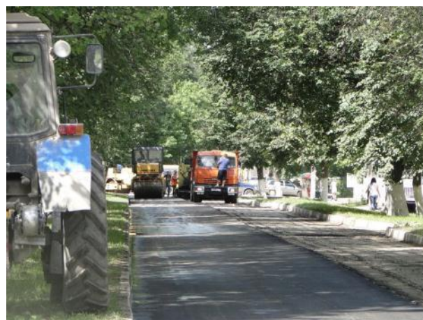
Уплотнение дорожного покрытия
