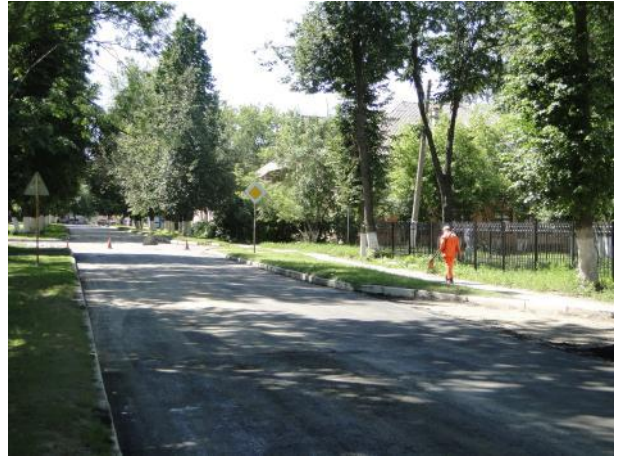
Завершение ремонта участка дороги
