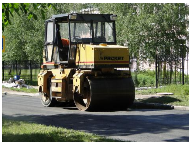
Уплотнение дорожного полотна
