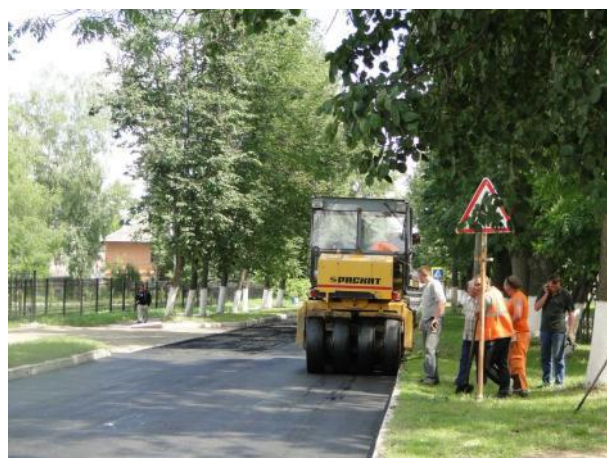
Уплотнение дорожного покрытия
