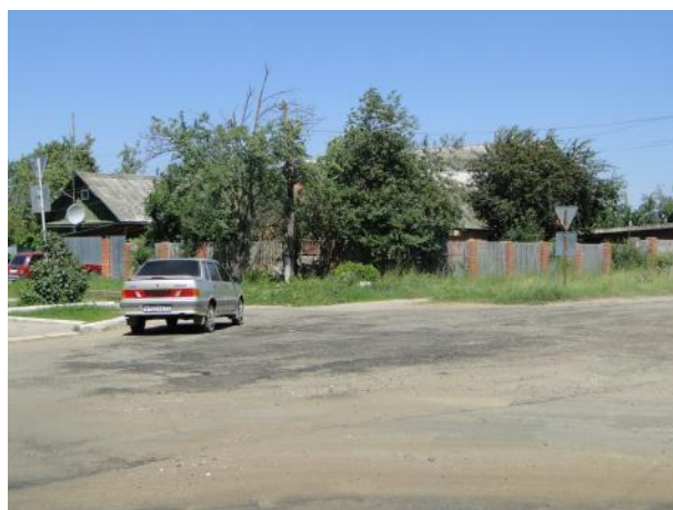
Выравнивание дорожной поверхности
