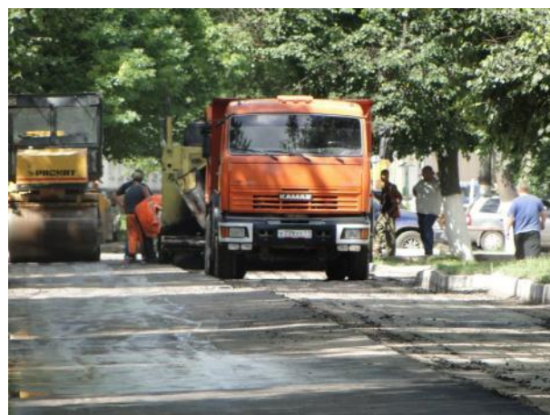
Уплотнение дорожного покрытия
