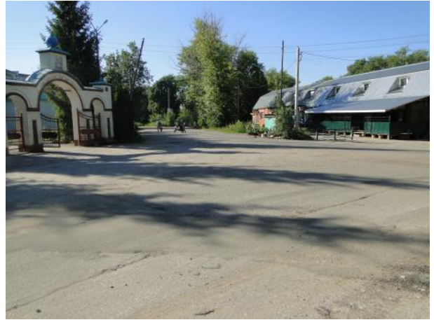
ул. Свободы. Ямочный ремонт
