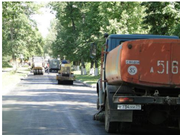
Уплотнение дорожного полотна
