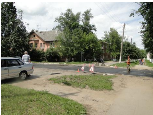
Укладка дорожной одежды
