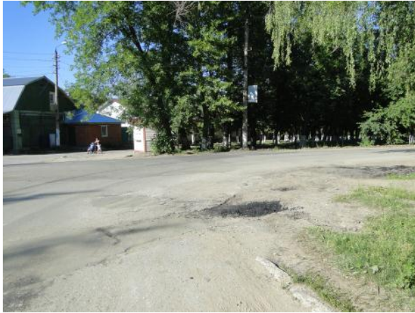
ул. Свободы. Ямочный ремонт
