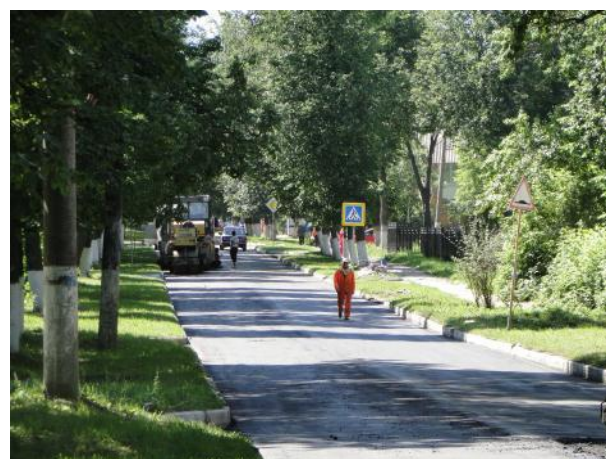
Укладка выравнивающего слоя
