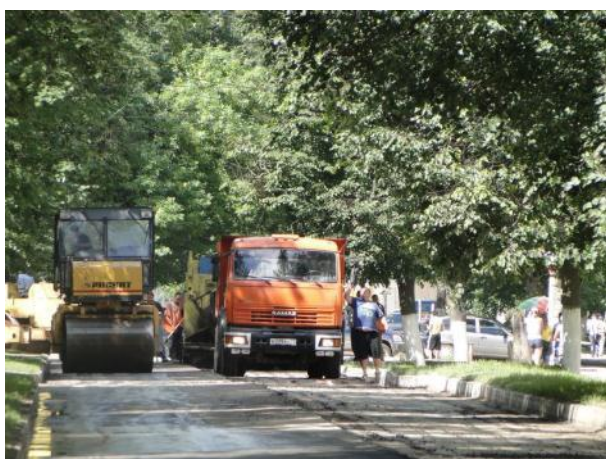
Укладка выравнивающего слоя
