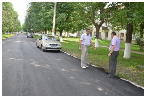
Осмотр отремонтированной дороги
