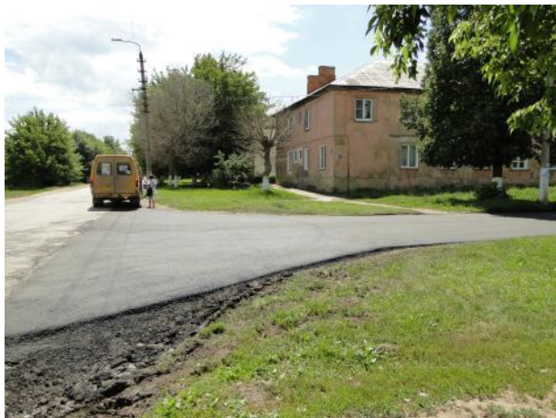
Перекресток с ул. Революции уложенный асфальт
