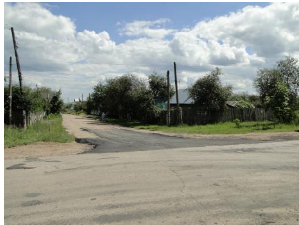
Перекресток с ул. Революции, съезд в частный сектор, подготовка поверхности
