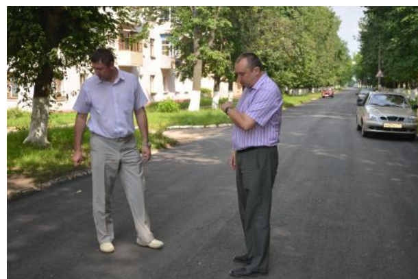
Осмотр отремонтированной дороги
