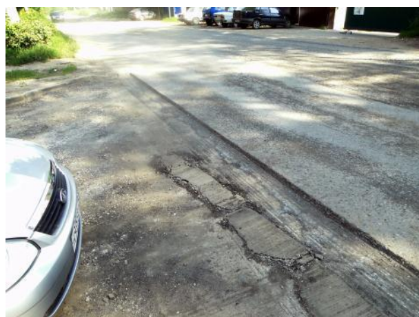
Фрезерование стыка дороги
