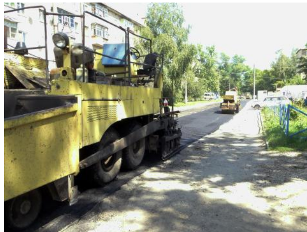
Укладка полосы асфальта
