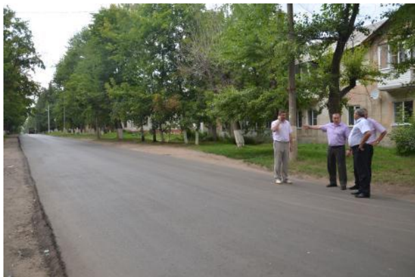
Осмотр отремонтированной дороги
