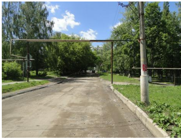
Фрезерование дорожного покрытия
