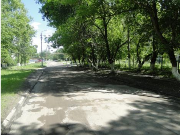
Фрезерование дорожного покрытия
