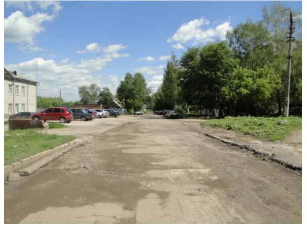
Фрезерование дорожного покрытия
