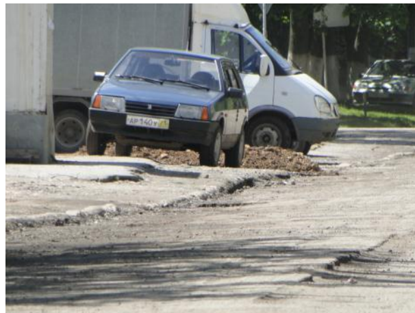
Фрезерование дорожного покрытия
