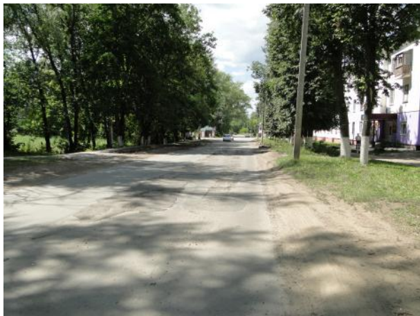
д.24 вид на перекресток с ул. Ленина Подготовка поверхности
