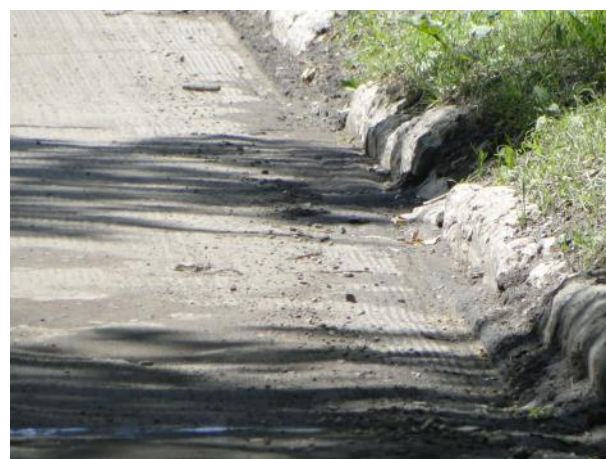
Фрезерование дорожного покрытия
