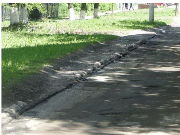
Фрезерование дорожного покрытия
