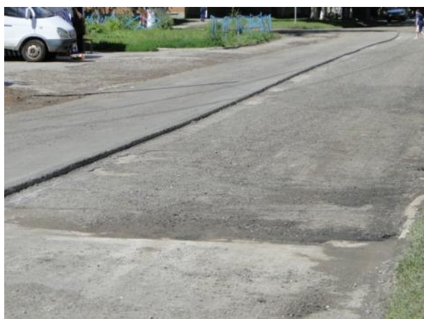
Уложенная полоса дороги
