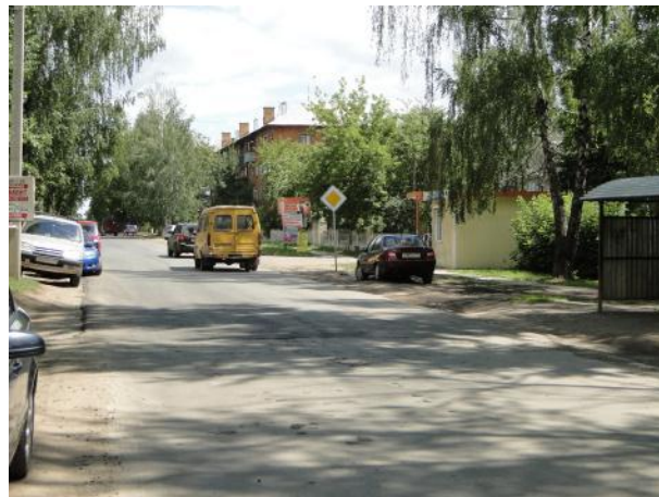
д.24 вид на перекресток с ул. Шахтерской Укладка асфальта
