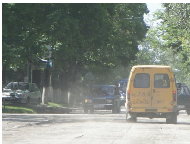
Фрезерование дорожного покрытия
