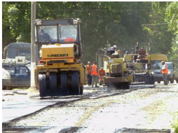
Укладка полосы асфальта
