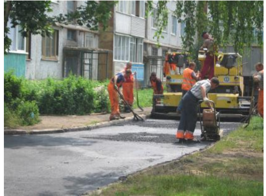
д. 9 Укладка асфальта
