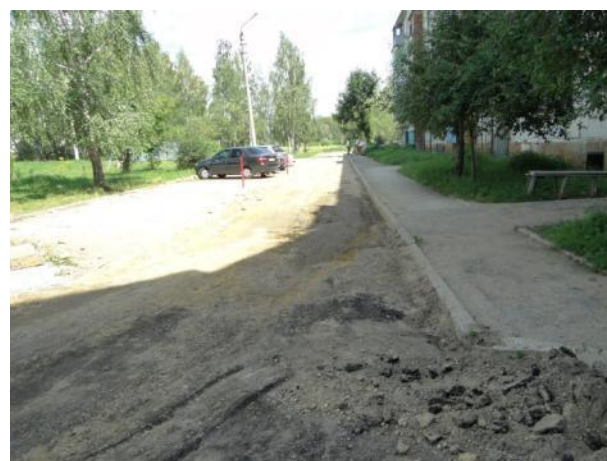
д. 9. Подготовка поверхности
