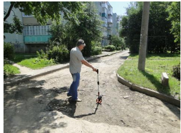
Измерение фронта работ
