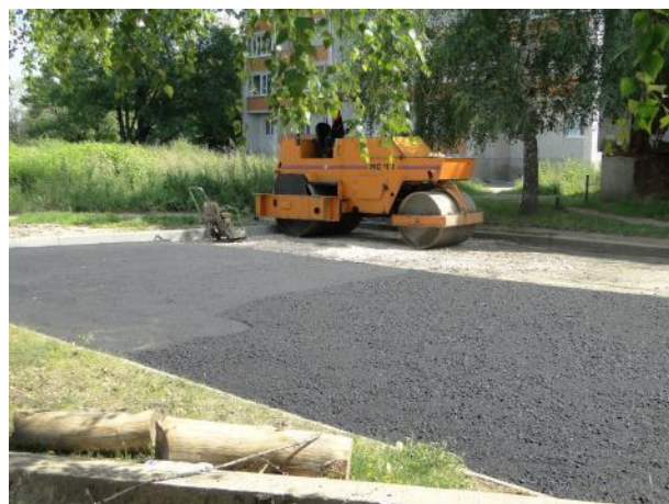
д. 13 Укладка асфальта
