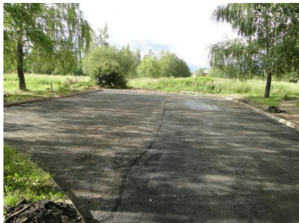
д. 13 Оборудование парковки
