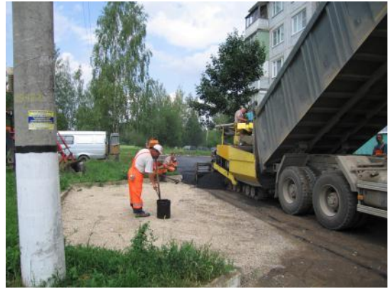
д. 9 Укладка асфальта
