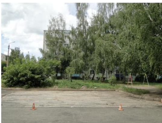
д. 11а Укладка асфальта
