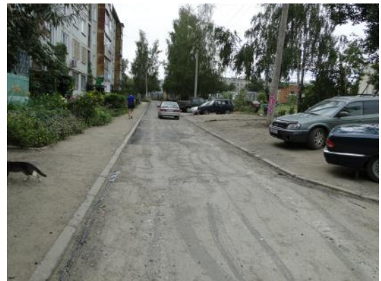
д. 9 Подготовка поверхности
