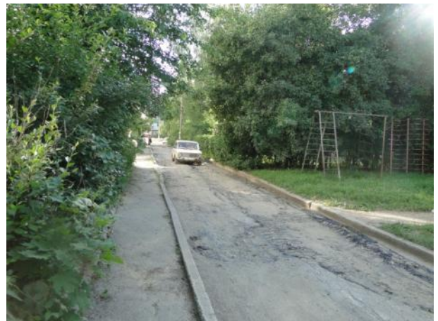
Ясенковский проезд, 13, 13-а. Проливка битумом
