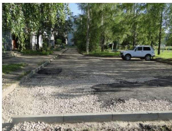
Ясенковский проезд, 13. Ямочный ремонт
