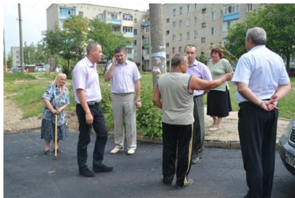
д. 13 Осмотр отремонтированных участков дороги
