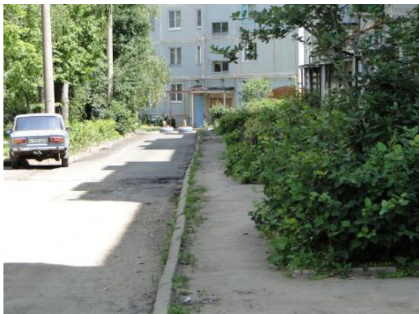
д. 13а Устройство асфальтового покрытия
