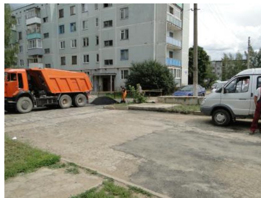
д. 11а Укладка асфальта
