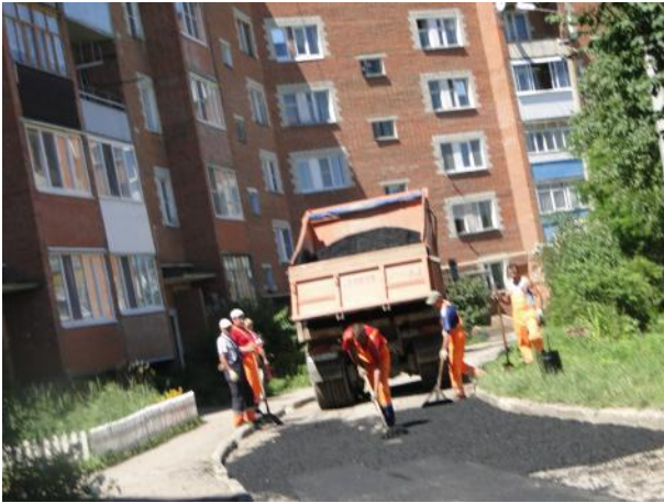
Укладка выравнивающего слоя
