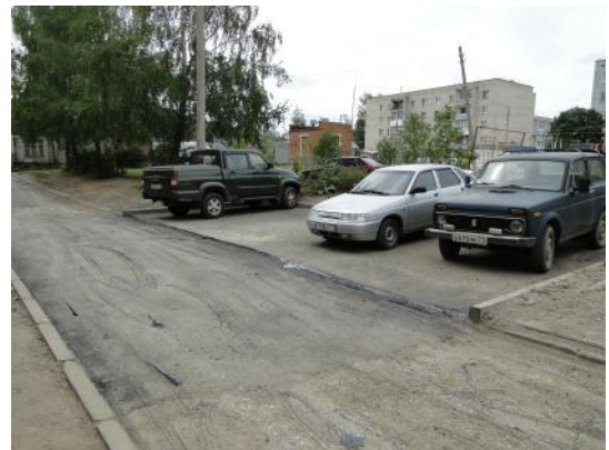
д. 9 Подготовка поверхности
