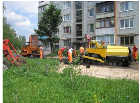
д. 9 Укладка асфальта
