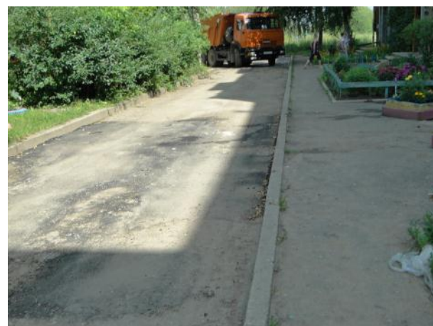
д. 13 Подготовка поверхности
