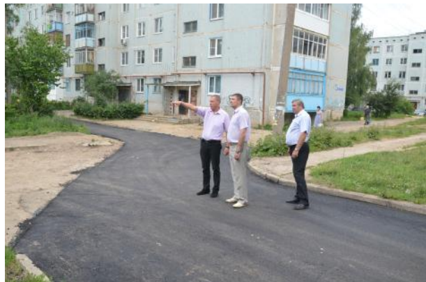
д. 13 Осмотр отремонтированных участков дороги
