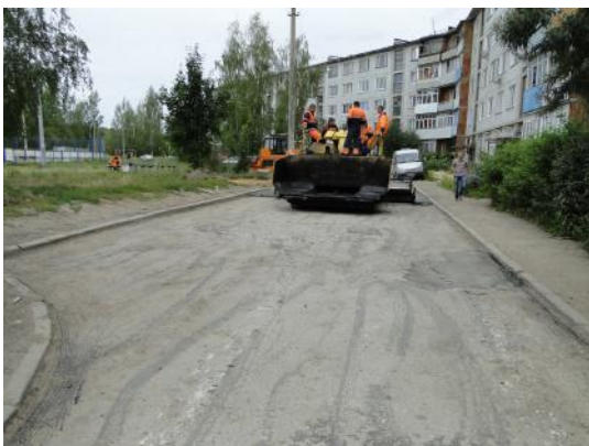
д. 9 Укладка асфальта
