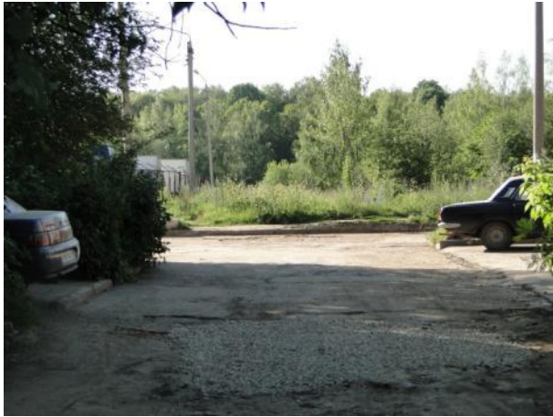
Выравнивание уплотненным щебнем
