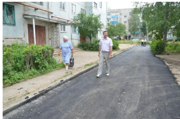
д. 13 Осмотр отремонтированных участков дороги
