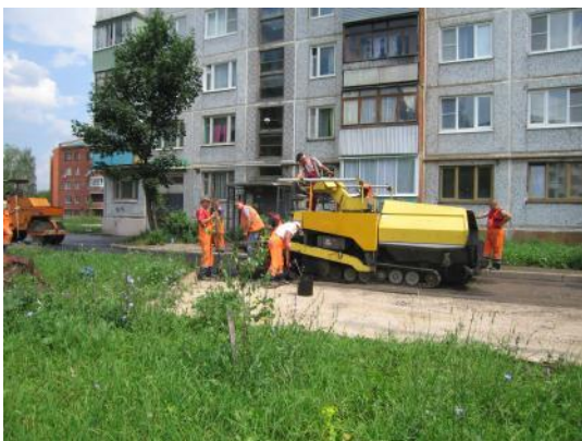
д. 9 Укладка асфальта
