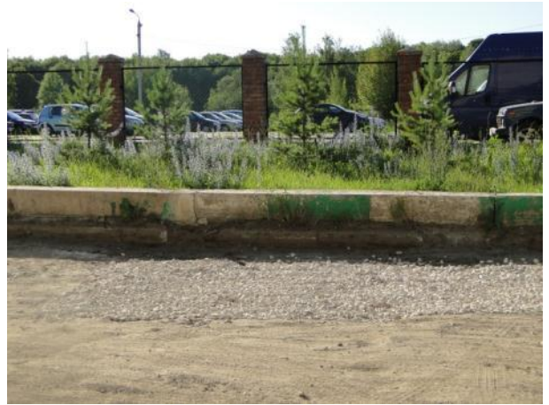
Выравнивание уплотненным щебнем
