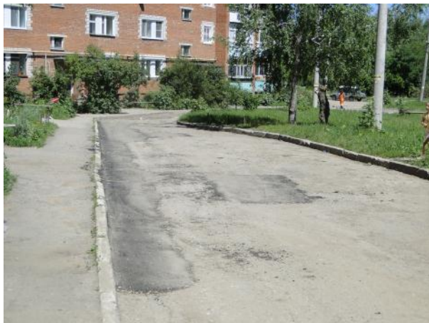
Подготовка поверхности
