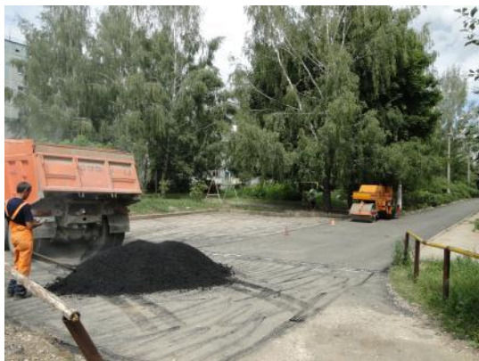
д. 11а Укладка асфальта
