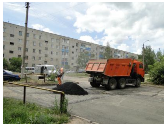
д. 11а Укладка асфальта
