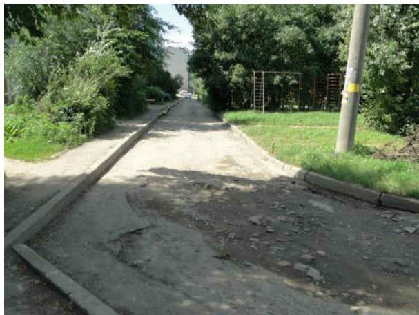
д. 11а До ремонта
