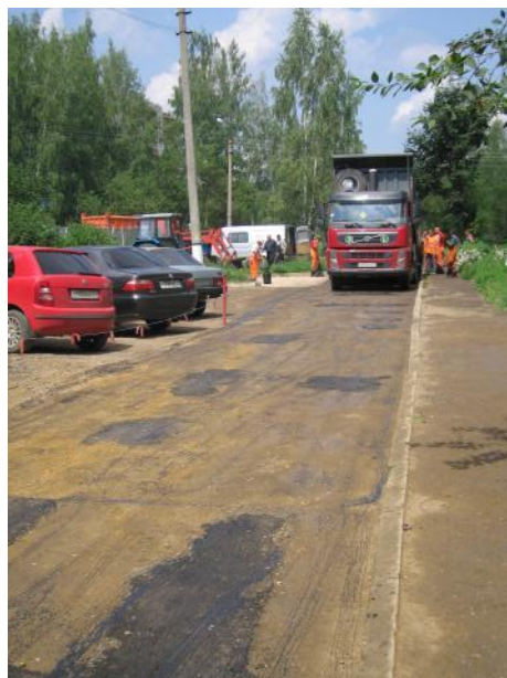
д. 9 Укладка асфальта
