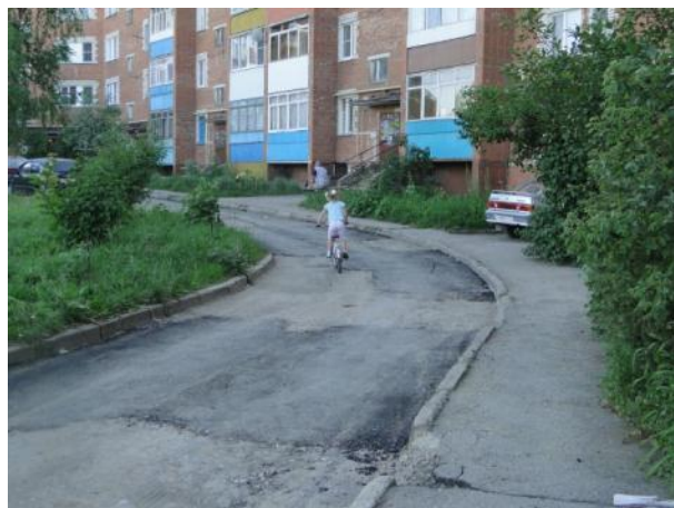
Гагарина, 14. Ямочный ремонт
