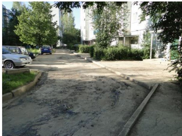
Ясенковский проезд, 13, 13-а. Проливка битумом
