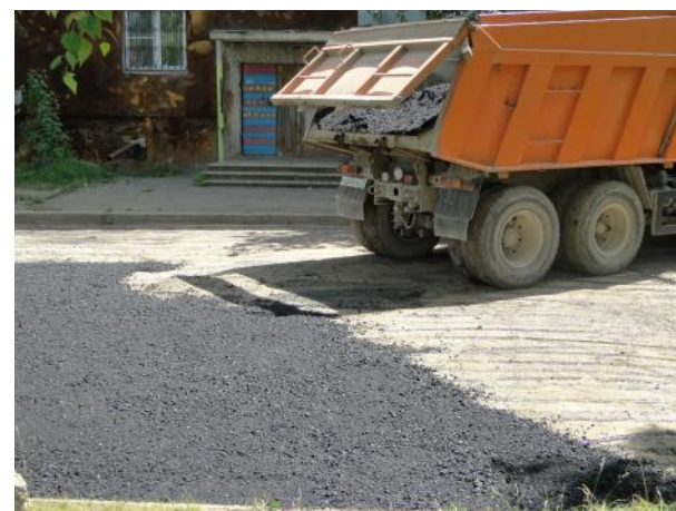
д. 13 Укладка асфальта
