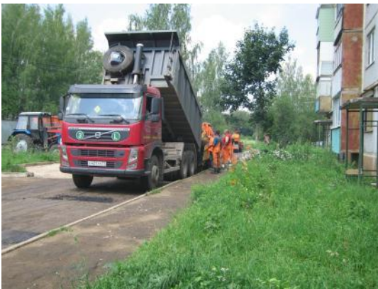
д. 9 Укладка асфальта
