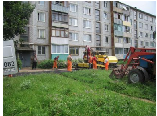
д. 9 Укладка асфальта
