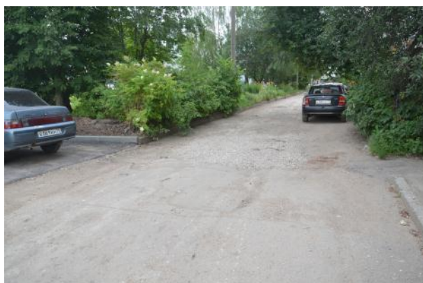
Оборудование парковочных карманов
