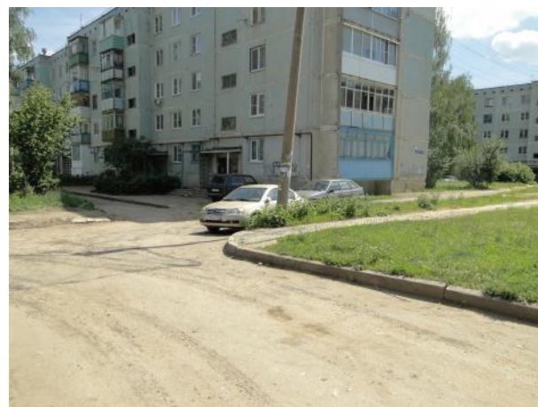
д. 13 Подготовка поверхности
