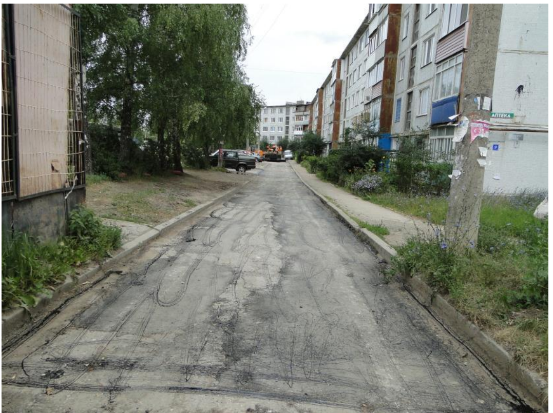
д. 9 Укладка асфальта
