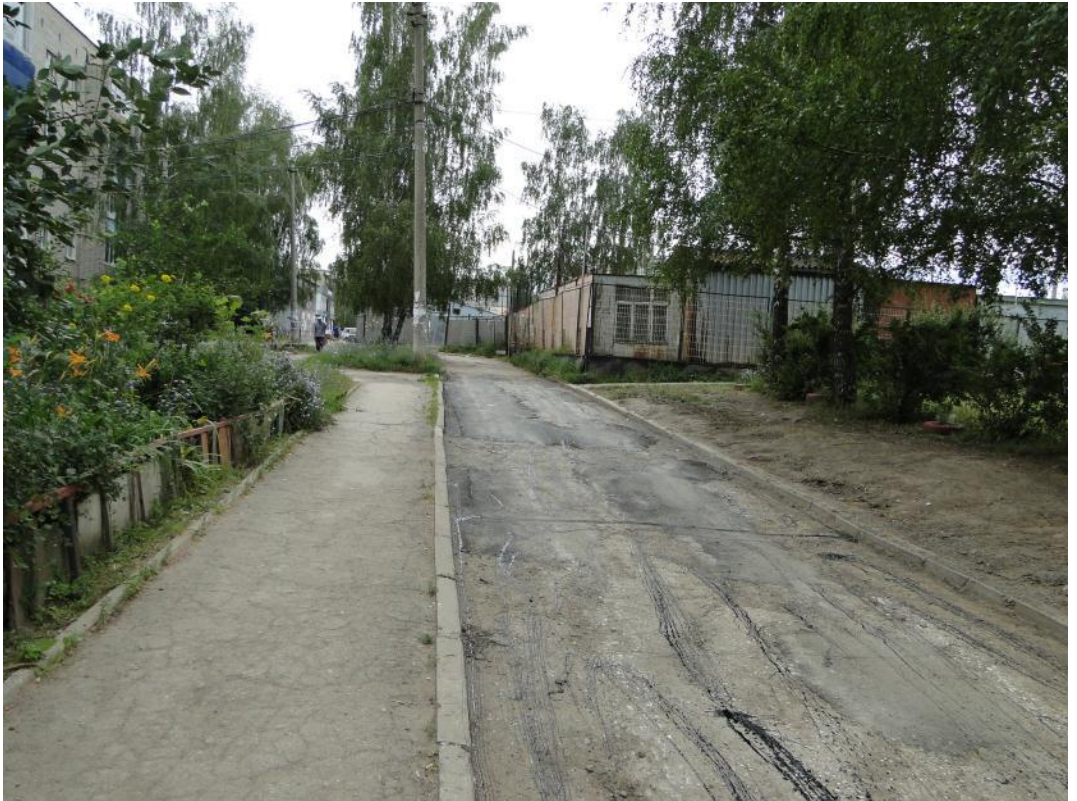
д. 9 Подготовка поверхности
