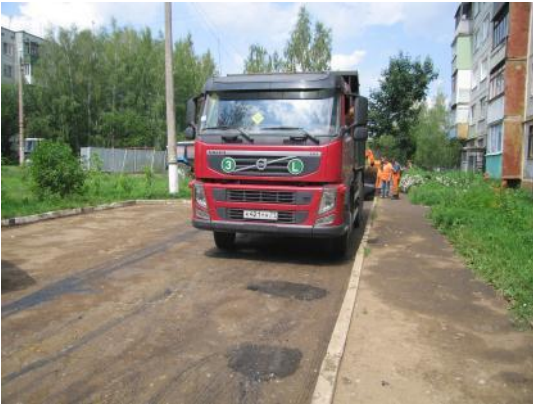
д. 9 Укладка асфальта
