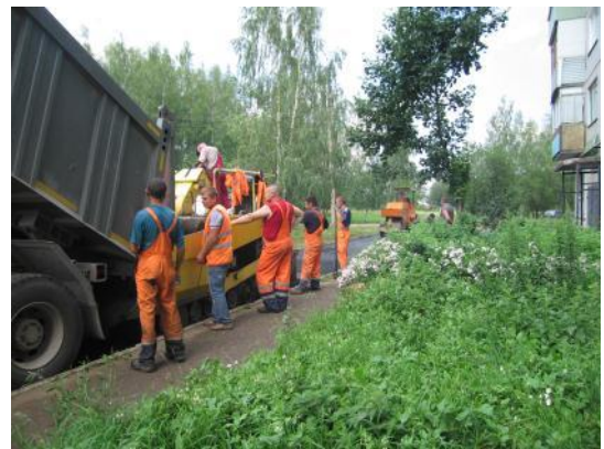
д. 9 Укладка асфальта
