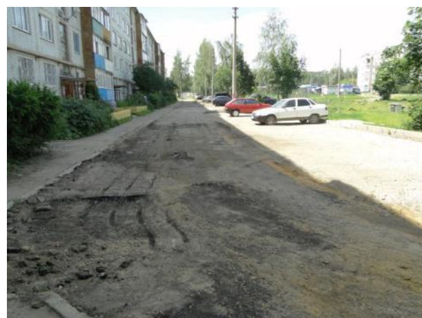
д. 9 Подготовка поверхности
