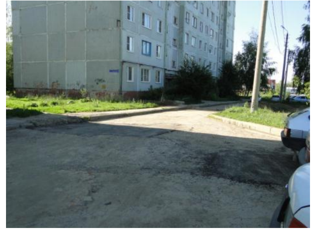
Гагарина, 16. Ямочный ремонт
