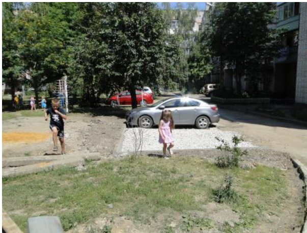
Оборудование парковочных карманов
