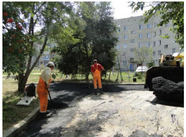
д.2 Укладка асфальта
