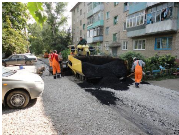
д.8 Укладка асфальта
