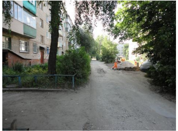
д.4 Подготовка поверхности
