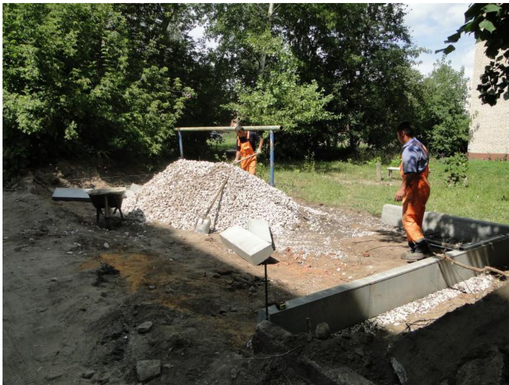
д.6 Оборудование парковочного кармана
