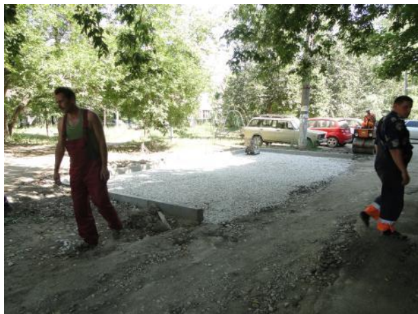
д.8 Оборудование парковочного кармана
