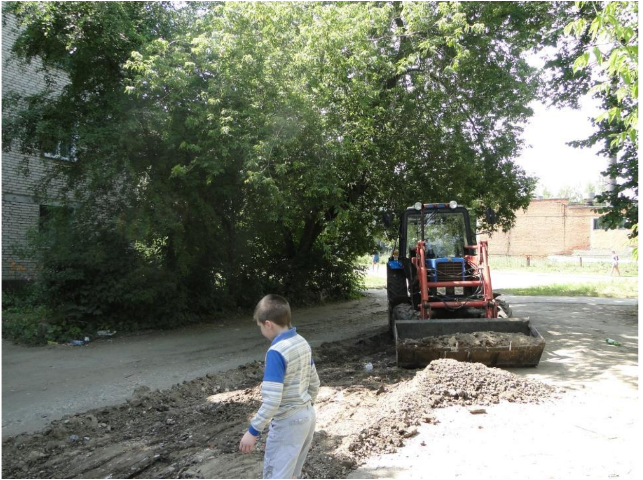
д.8 Подготовка поверхности
