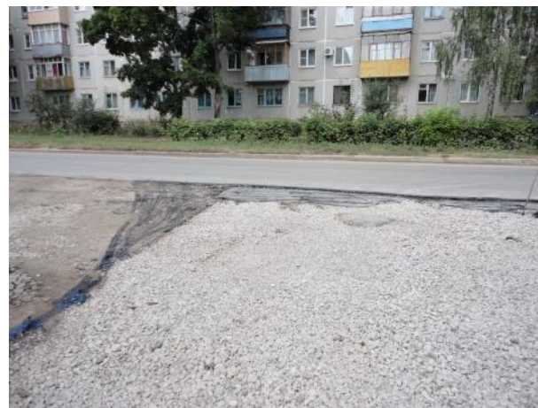
Устройство выравнивающего слоя
