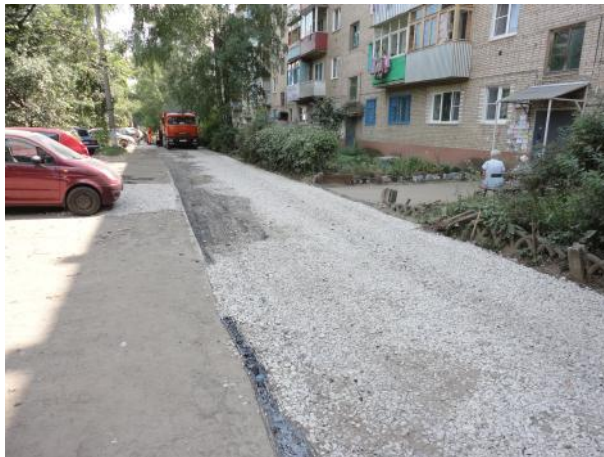
д.8 Устройство выравнивающего слоя
