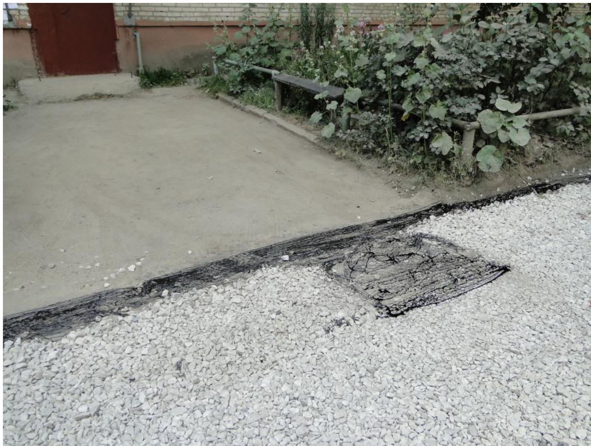
Устройство выравнивающего слоя
