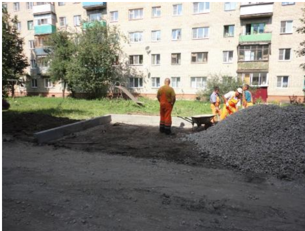
д.4 Оборудование парковочных карманов
