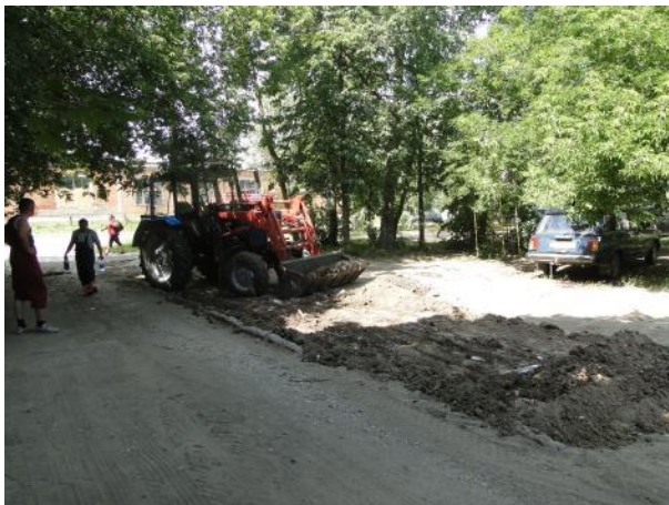
д.8 Подготовка поверхности
