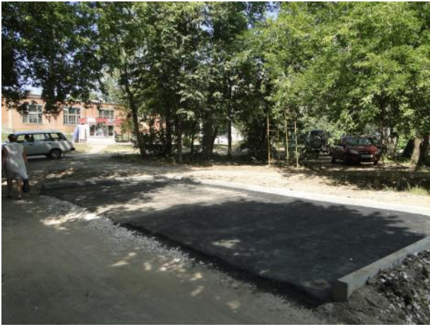
д.8 Оборудование парковочного кармана
