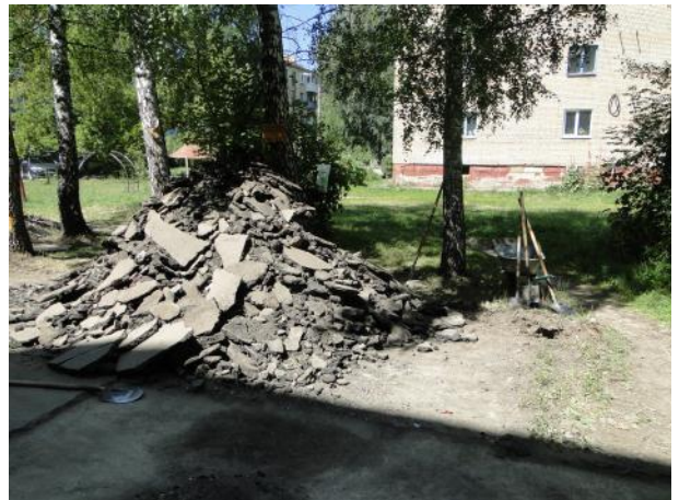
д.8 Подготовка поверхности
