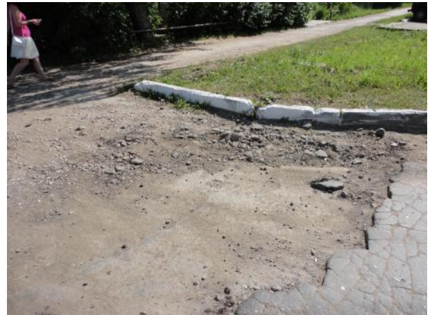
д. 4 Подготовка поверхности
