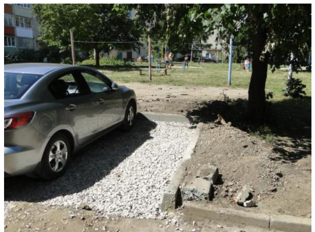
Оборудование парковочных карманов
