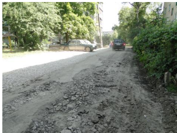
д.8 Устройство выравнивающего слоя
