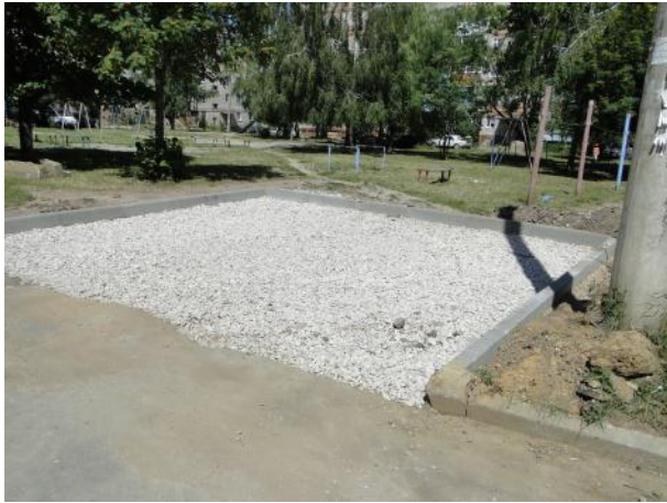
Оборудование парковочных карманов
