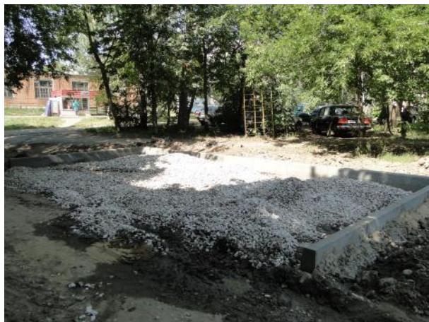
д.8 Устройство выравнивающего слоя
