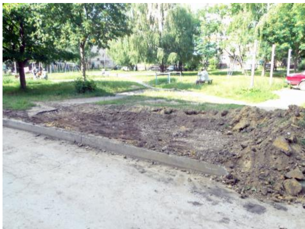
д.2 Подготовка поверхности
