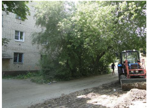
д.8 Подготовка поверхности
