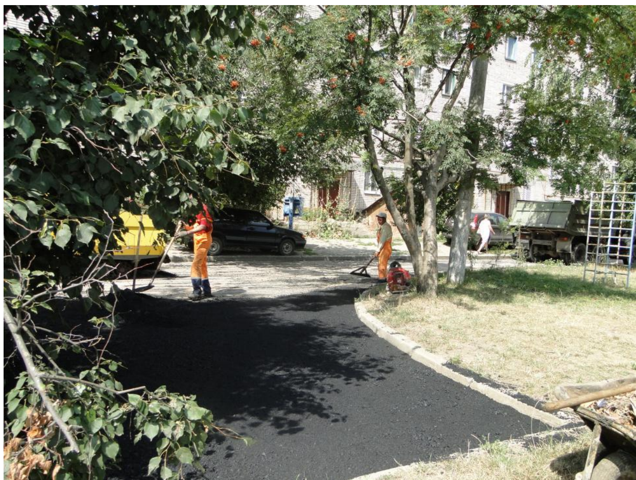
д.2 Укладка асфальта
