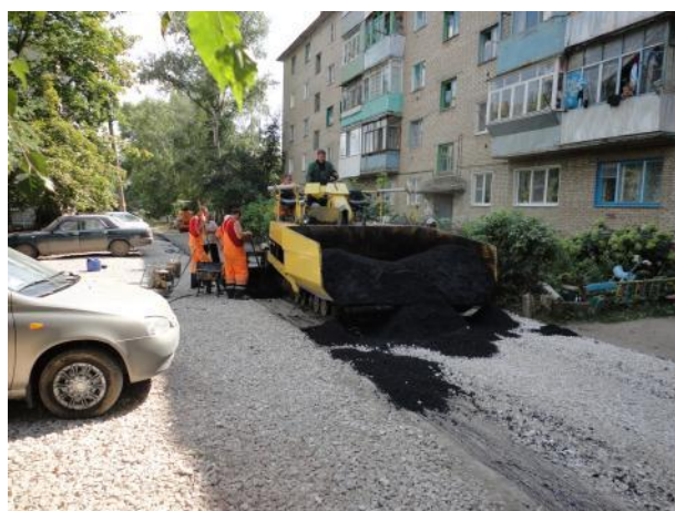
д.8 Укладка асфальта
