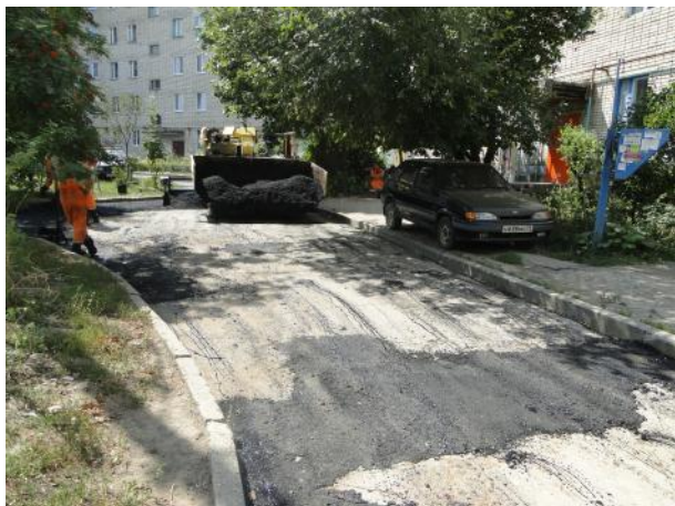
д.2 Укладка асфальта
