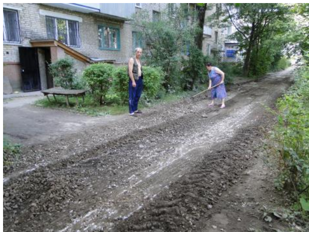
д.6 Выравнивание поверхности
