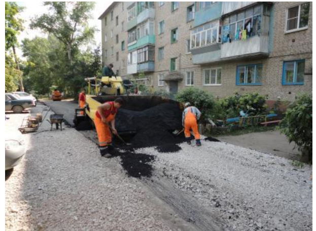
д.8 Укладка асфальта
