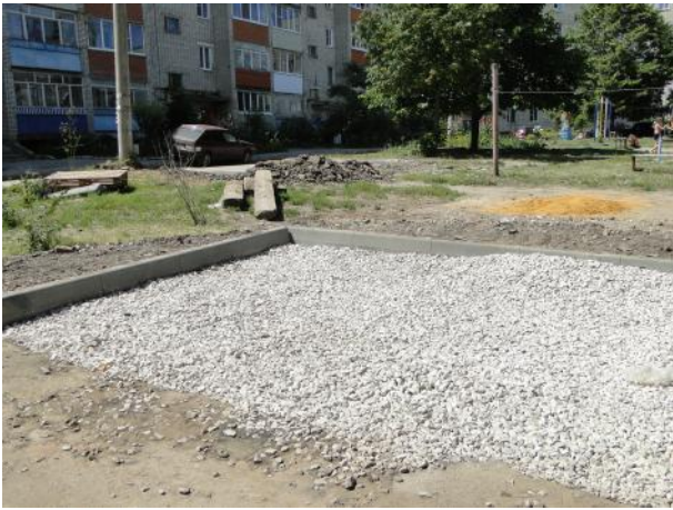
Оборудование парковочных карманов
