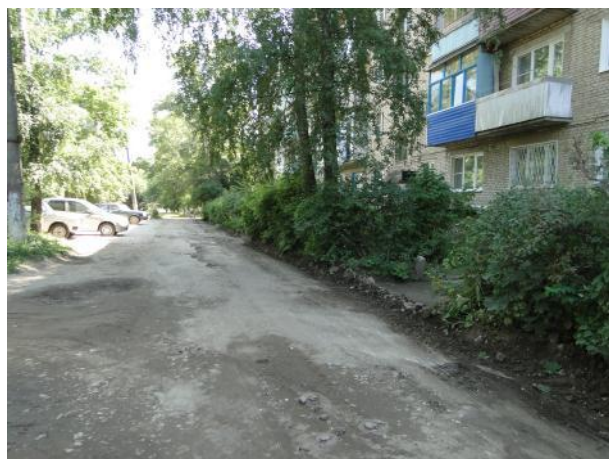
д.8 Устройство выравнивающего слоя
