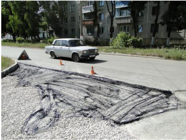
Оборудование стыка дороги
