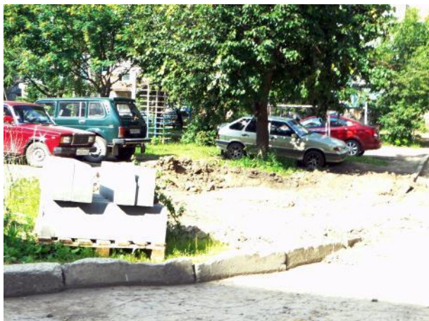
д.2 Подготовка поверхности
