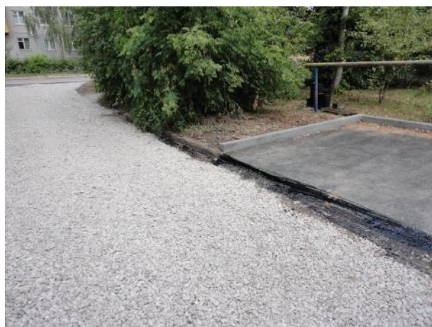
Устройство выравнивающего слоя
