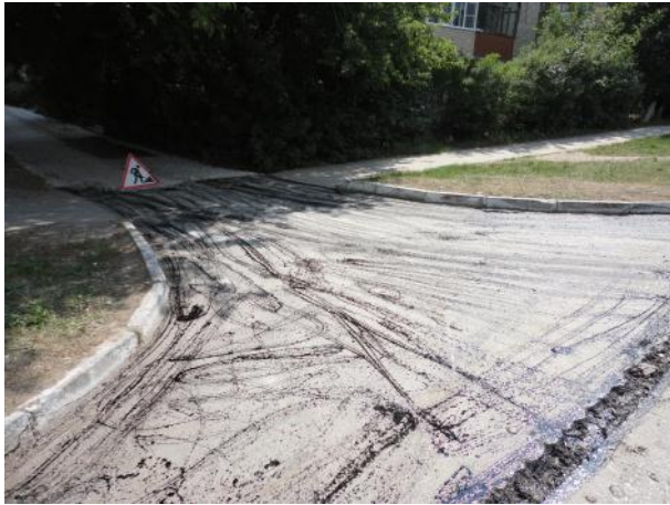
д.8 Подготовка поверхности
