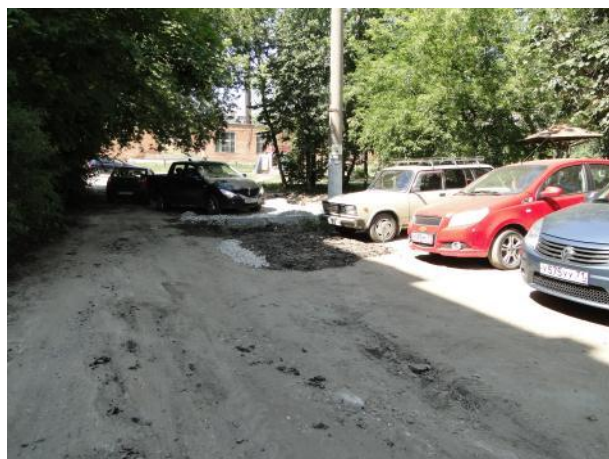
д.8 Устройство выравнивающего слоя
