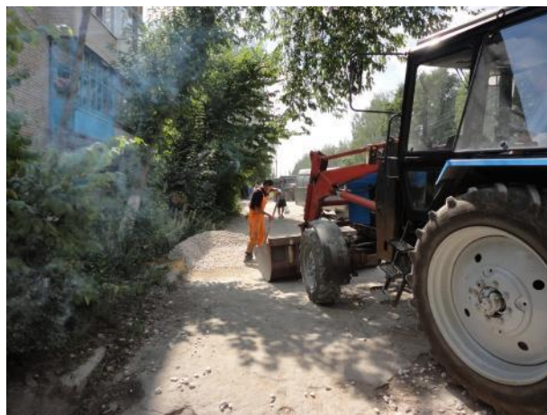
д.6 Устройство выравнивающего слоя
