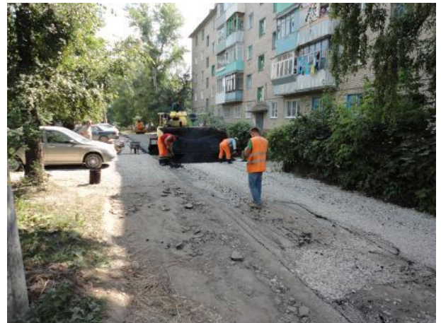
д.8 Укладка асфальта
