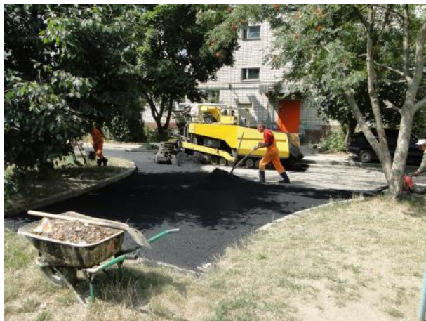
д.2 Укладка асфальта
