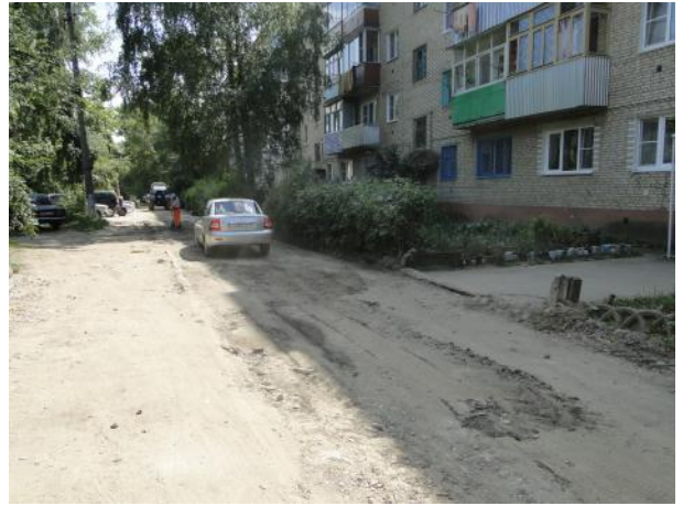
д.8 Подготовка поверхности
