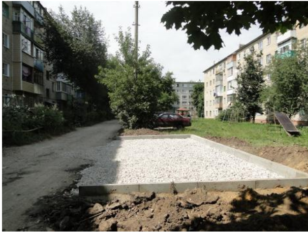
д.4 Оборудование парковочного кармана
