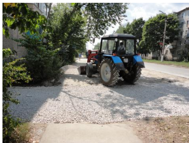
д.6 Устройство выравнивающего слоя
