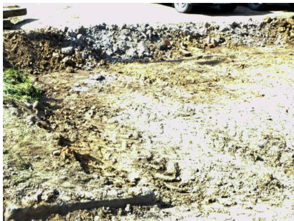
д.2 Подготовка поверхности
