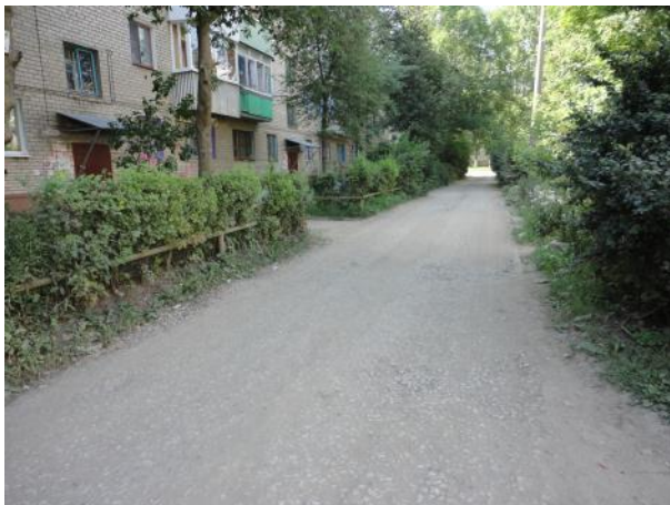
д. 4 Подготовка поверхности
