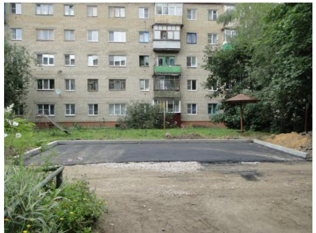
д.4 Оборудование парковочного кармана
