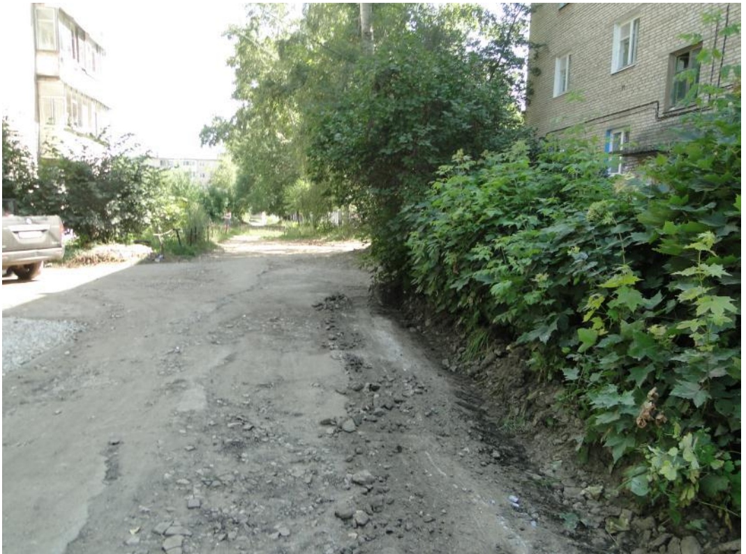
д.8 Устройство выравнивающего слоя
