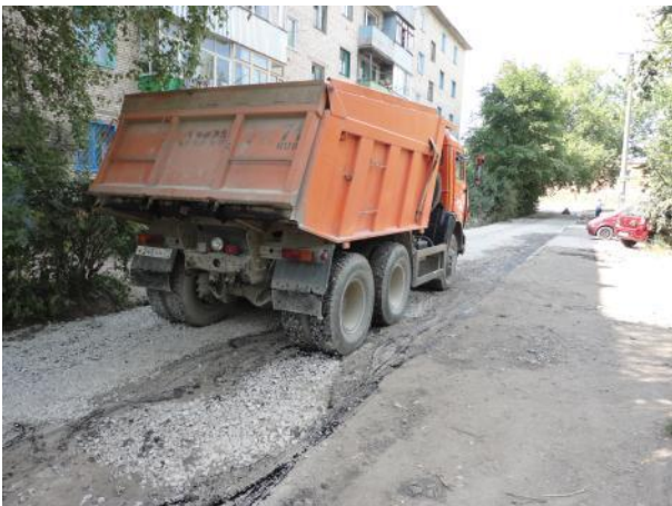
д.8 Укладка асфальта
