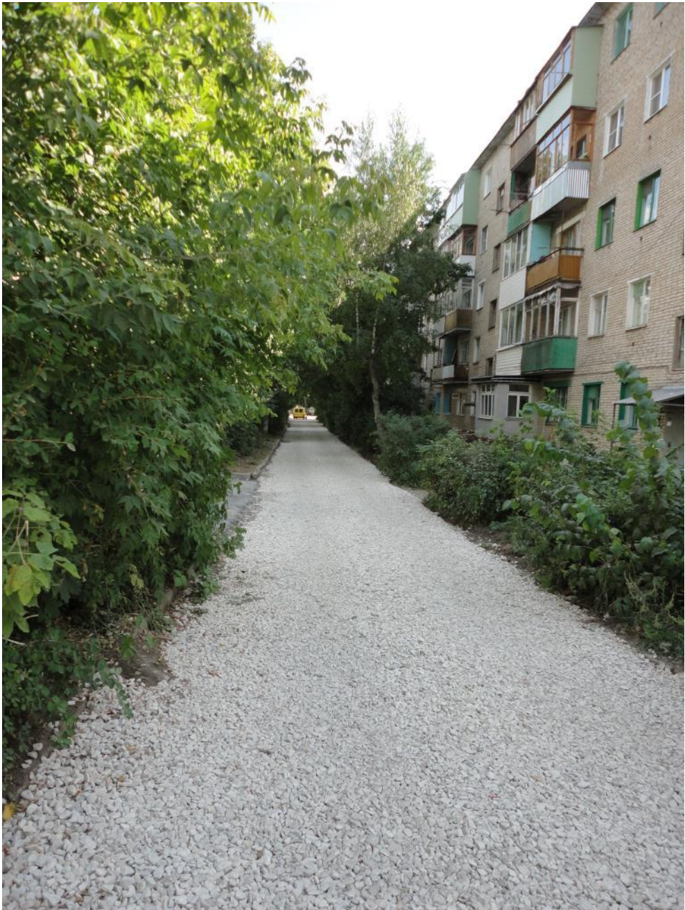
д.6 Устройство выравнивающего слоя
