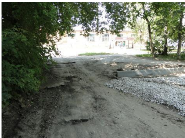
д.8 Устройство выравнивающего слоя
