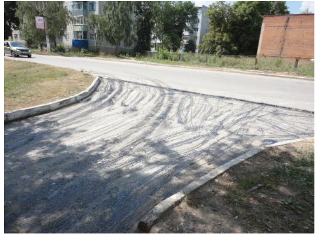
д.8 Подготовка поверхности
