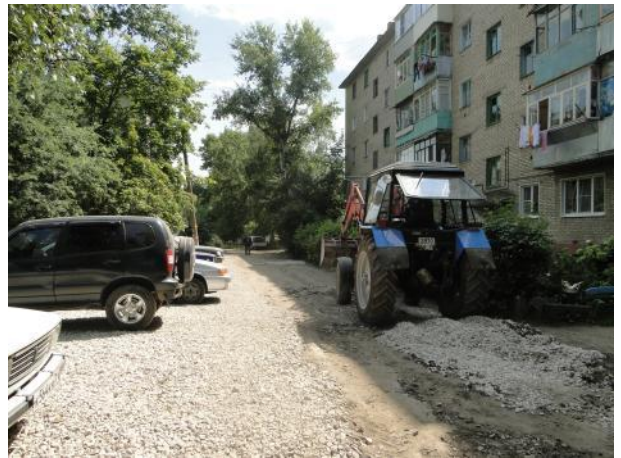
д.8 Выравнивание поверхности
