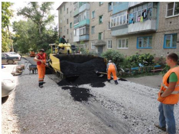
д.8 Укладка асфальта
