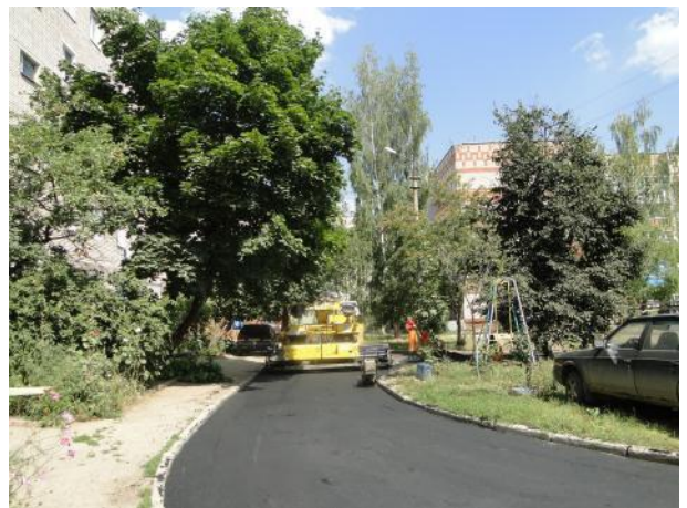
д.2 Укладка асфальта
