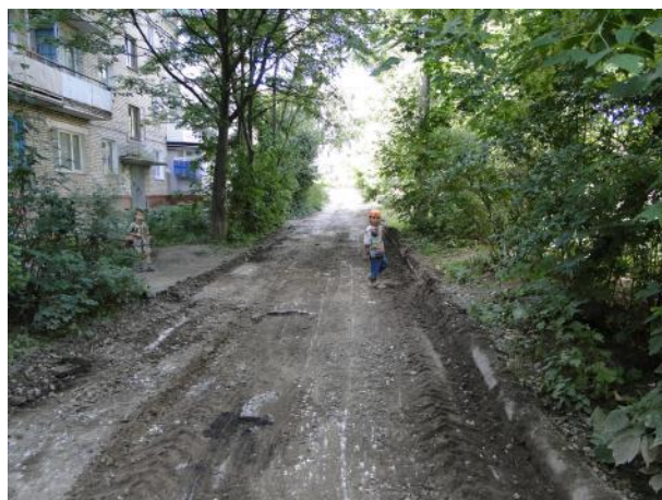
д.6 Выравнивание поверхности
