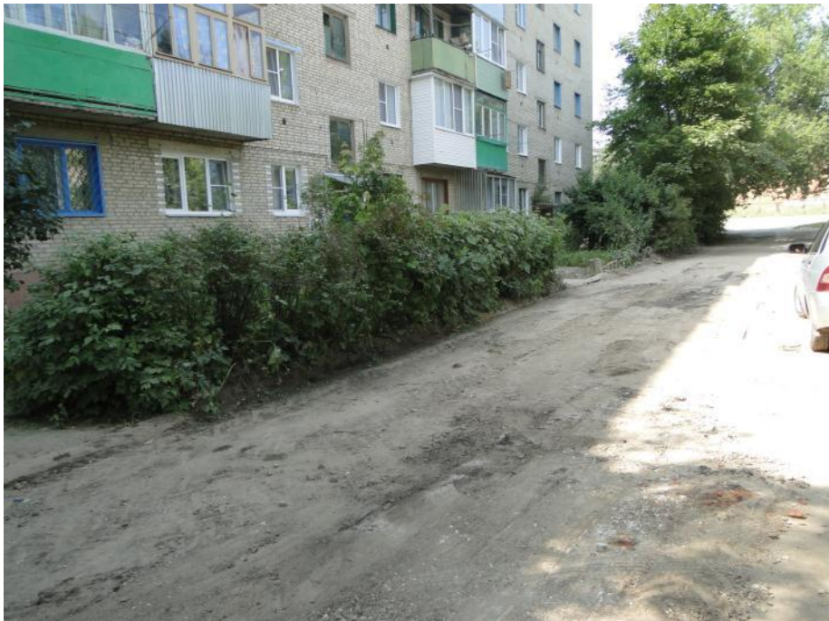
д.8 Подготовка поверхности
