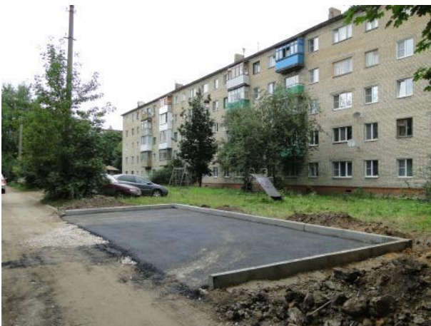
д.4 Оборудование парковочного кармана
