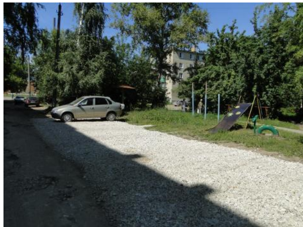
д.8 Устройство выравнивающего слоя
