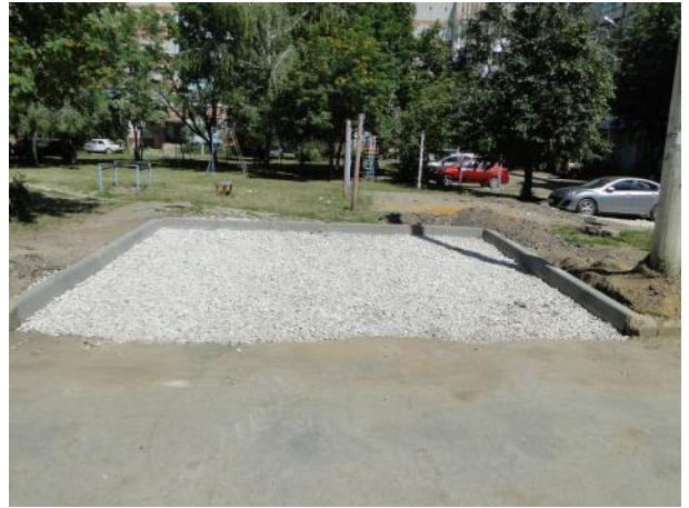
Оборудование парковочных карманов
