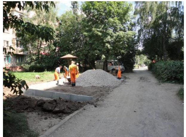
д.4 Оборудование парковочных карманов
