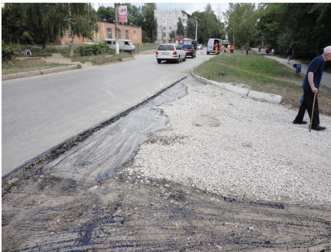
Устройство выравнивающего слоя
