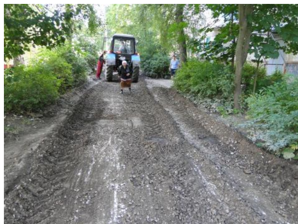
д.6 Выравнивание поверхности
