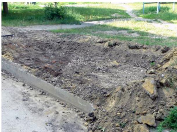
д.2 Подготовка поверхности
