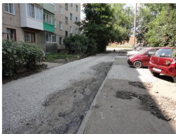
д.8 Устройство выравнивающего слоя
