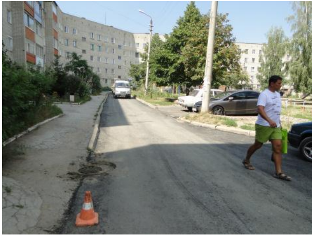
д.2 Дорожные работы
