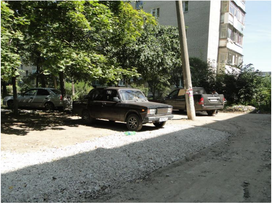
д.8 Устройство выравнивающего слоя
