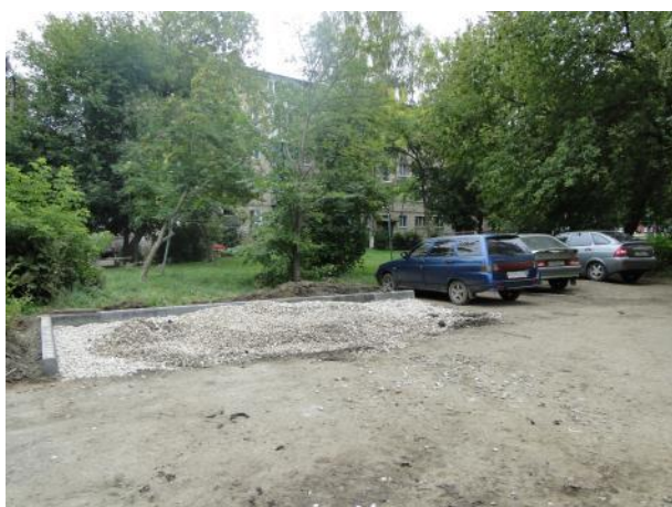
д. 3 Устройство выравнивающего слоя
