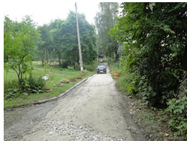
д. 5 Устройство выравнивающего слоя
