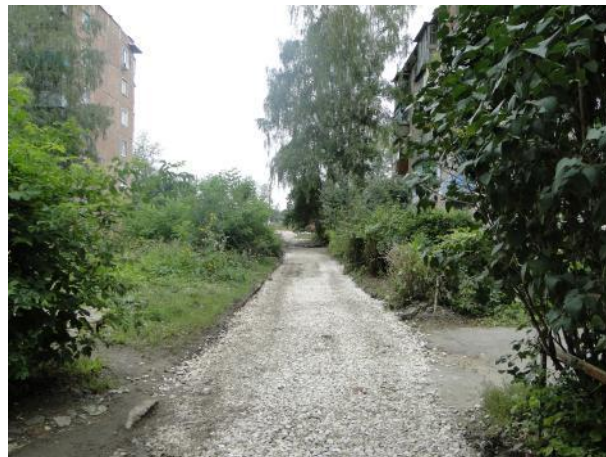
д. 3 Устройство выравнивающего слоя
