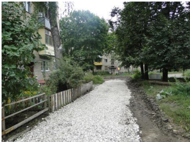
д. 3 Устройство выравнивающего слоя
