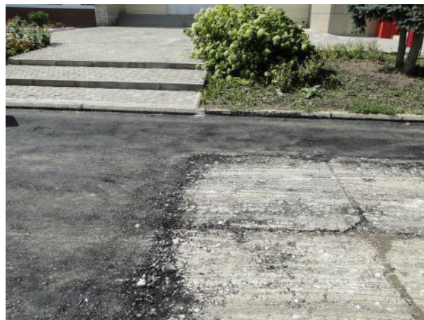
Устройство выравнивающего слоя
