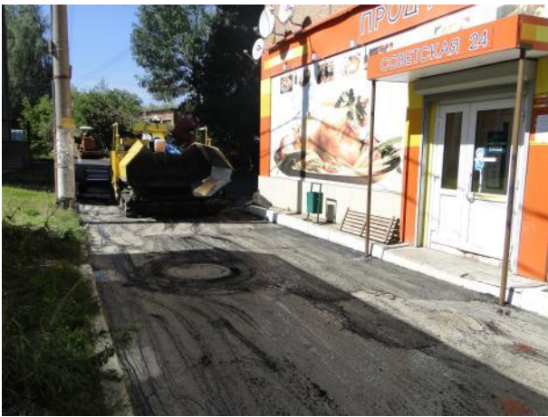
д. 24 Подготовка поверхности
