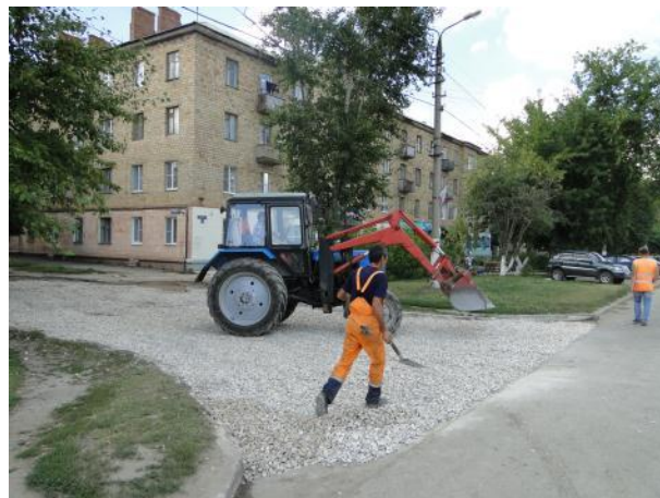
Устройство выравнивающего слоя
