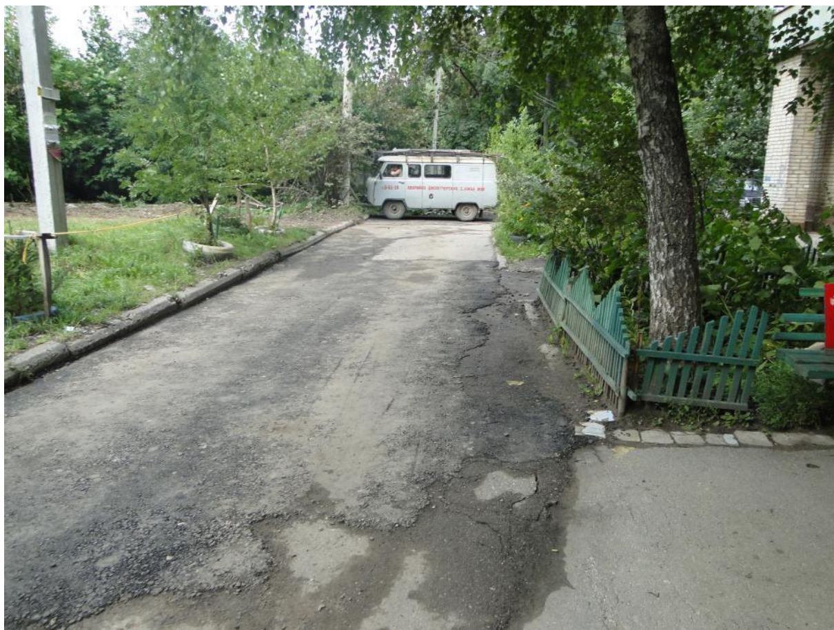
Устройство выравнивающего слоя
