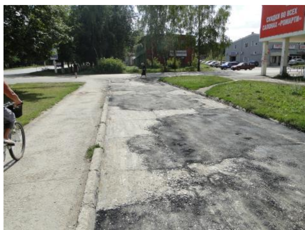
Устройство выравнивающего слоя
