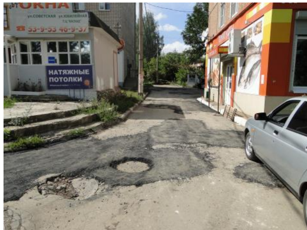
Устройство выравнивающего слоя
