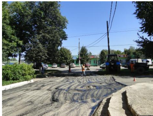
д. 26 Дорожные работы
