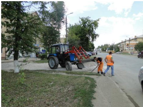
Устройство выравнивающего слоя
