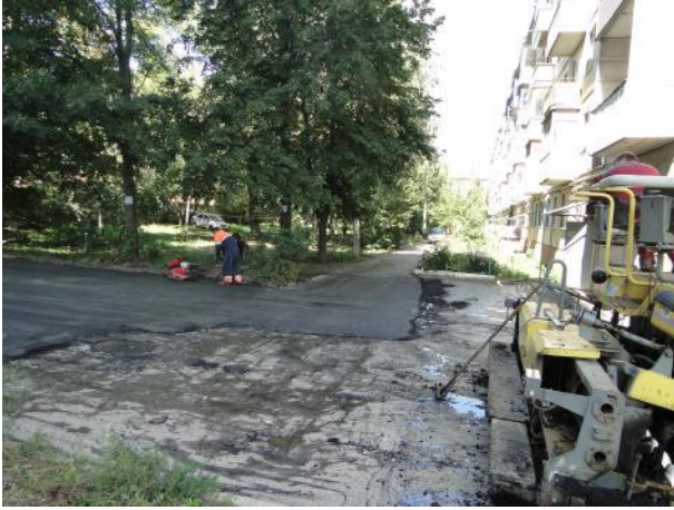
д. 26 Укладка асфальта
