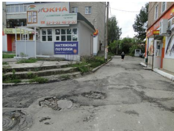
Устройство выравнивающего слоя
