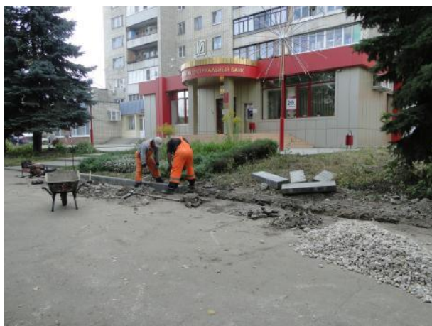
Установка бордюрного камня
