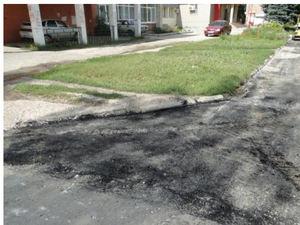
Устройство выравнивающего слоя
