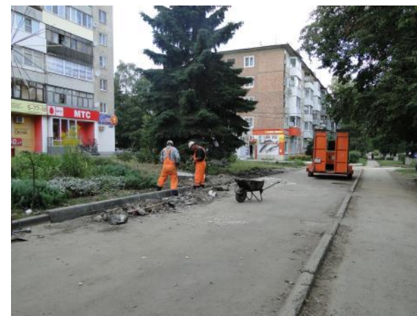
Установка бордюрного камня
