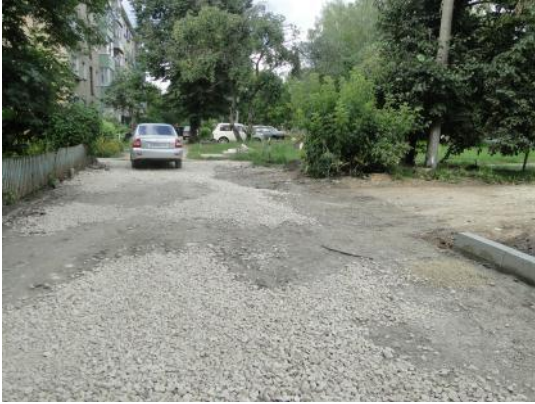
д. 46 Устройство выравнивающего слоя
