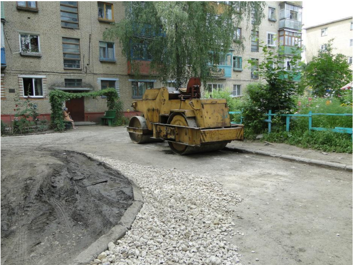
д. 44 Устройство выравнивающего слоя
