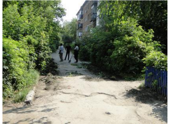
д. 40 Подготовка поверхности
