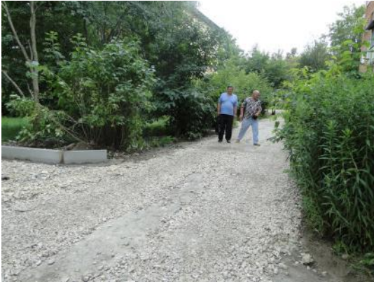
д. 40 Устройство выравнивающего слоя
