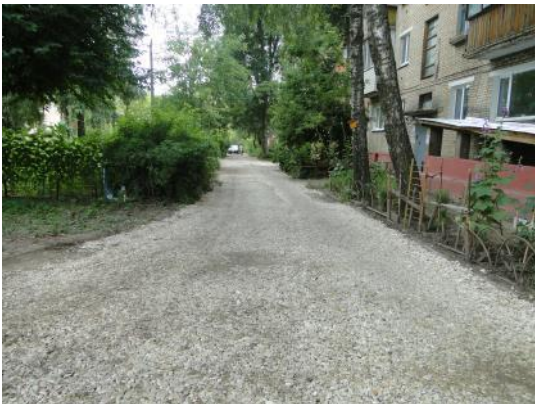
д. 46 Устройство выравнивающего слоя
