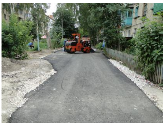
д. 46 Укладка асфальта
