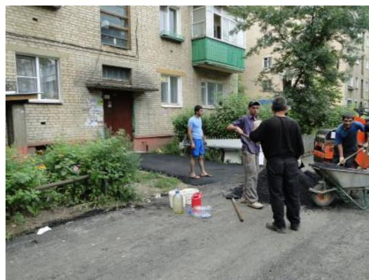
д. 46 Укладка асфальта
