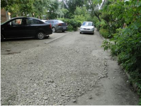
д. 42 Устройство выравнивающего слоя
