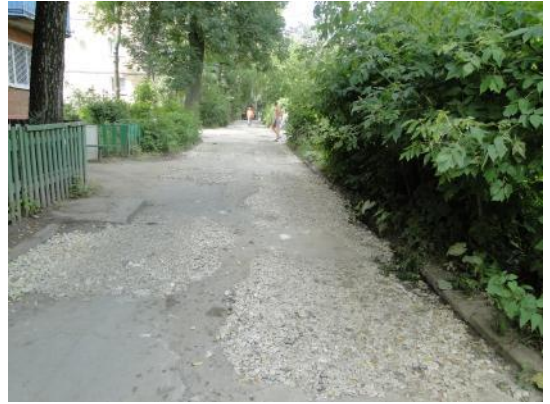
д. 42 Устройство выравнивающего слоя
