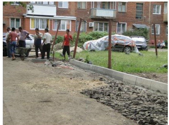
д. 40а Установка бордюрного камня
