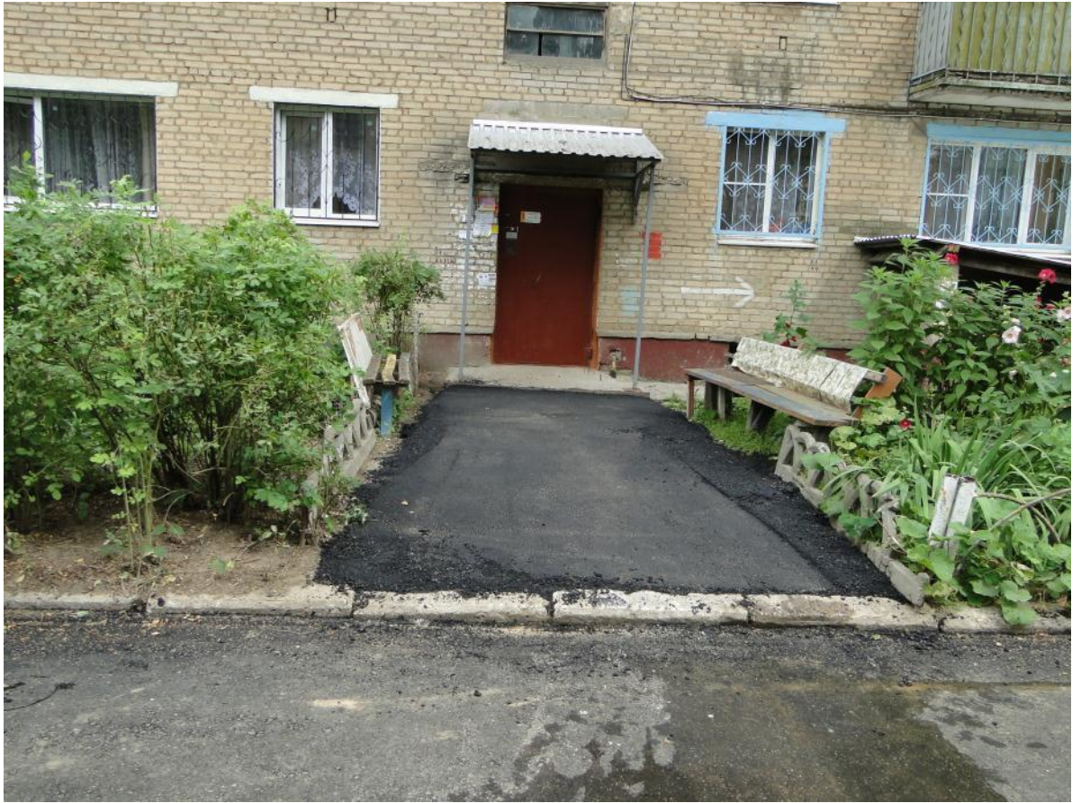
д. 46 Укладка асфальта
