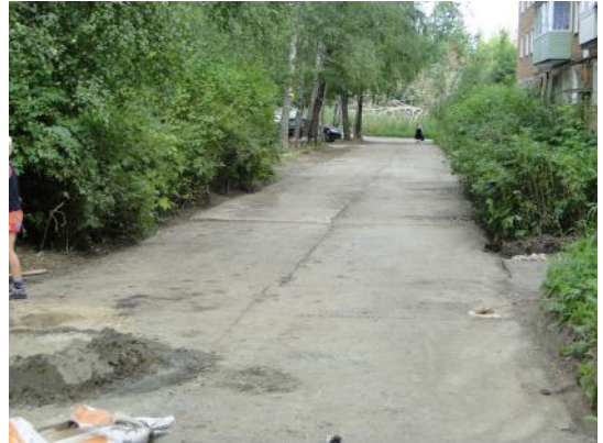
д. 40а Подготовка поверхности
