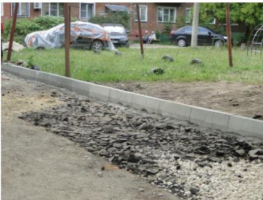
д. 40а Устройство выравнивающего слоя
