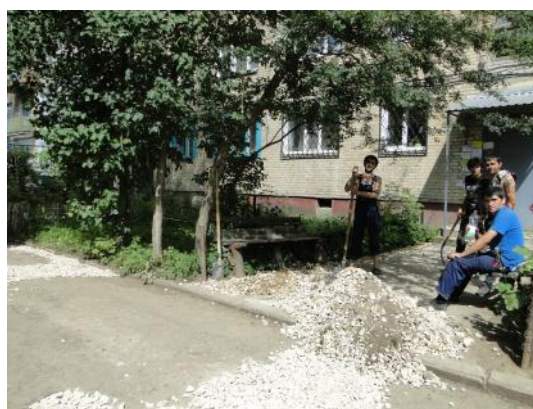
д. 44 Устройство выравнивающего слоя
