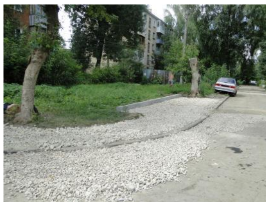
д. 44 Устройство выравнивающего слоя
