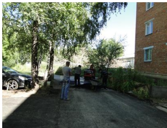
д. 40а Укладка асфальта
