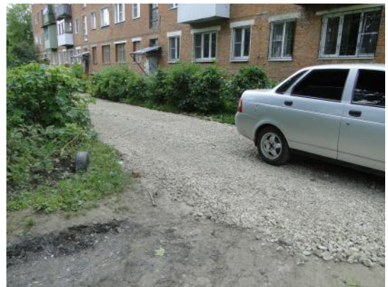
д. 40 Устройство выравнивающего слоя
