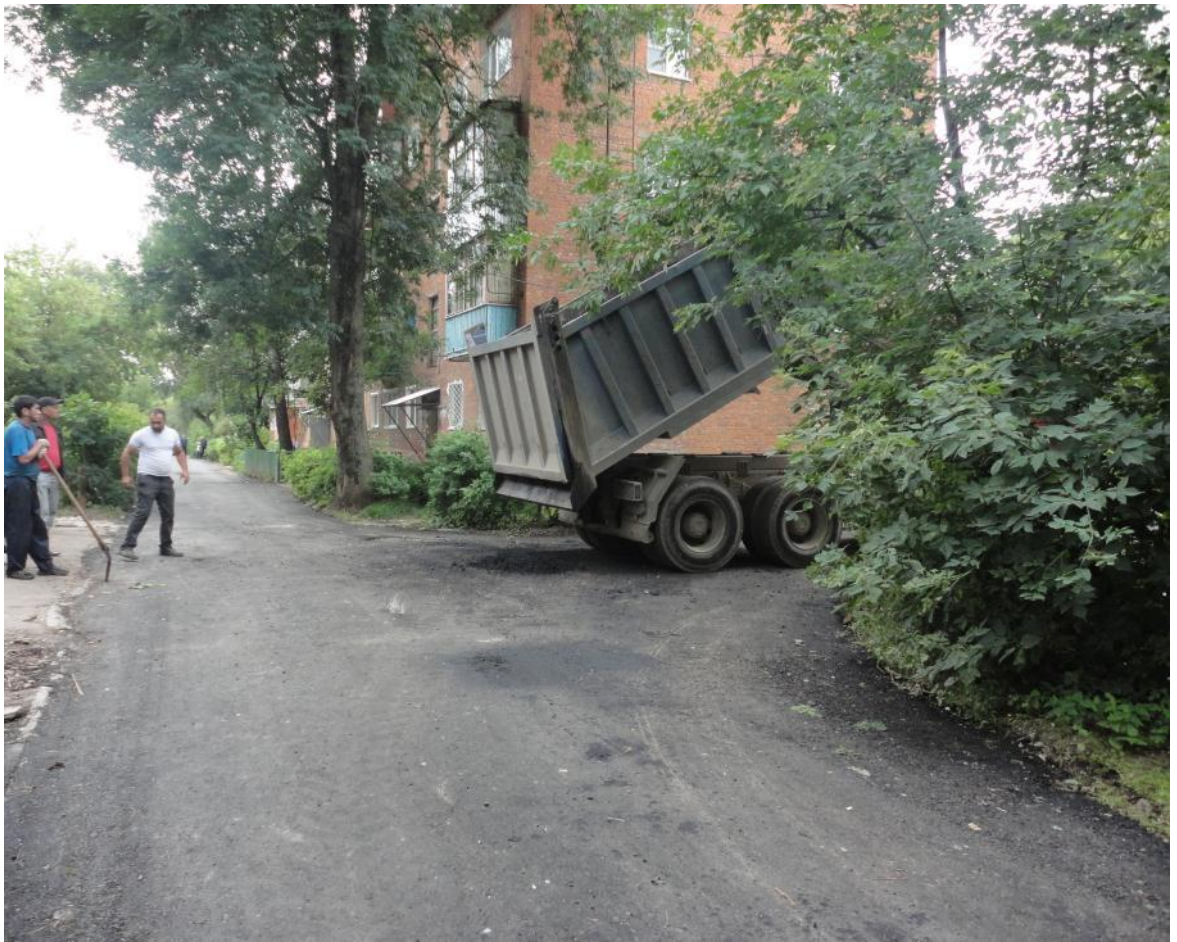
д. 46 Укладка асфальта
