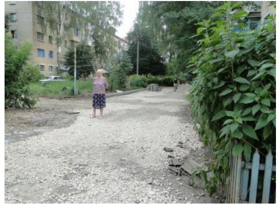
д. 46 Устройство выравнивающего слоя
