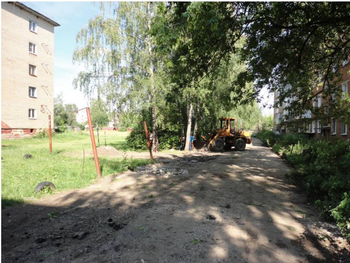
д. 40 Подготовка поверхности
