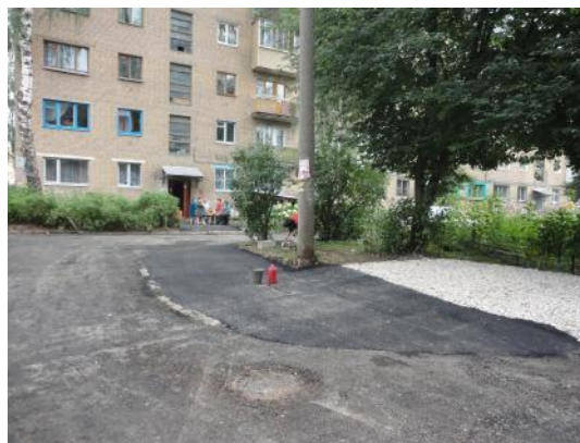
д. 46 Укладка асфальта
