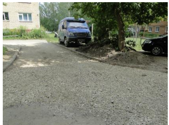
д. 42 Устройство выравнивающего слоя
