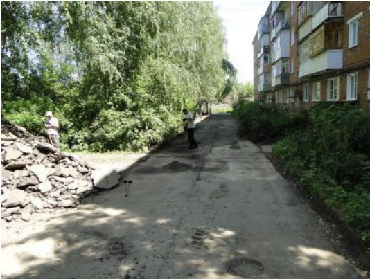
д. 40а Подготовка поверхности
