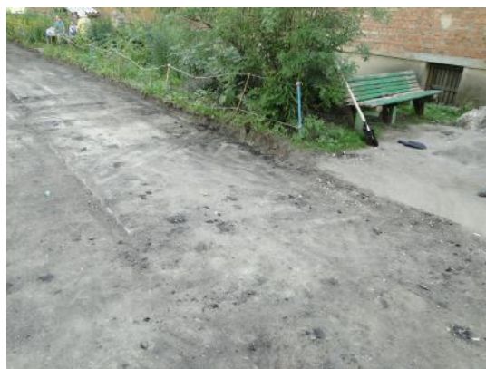
д. 40а Подготовка поверхности
