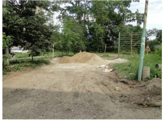
д. 46 Подготовка поверхности
