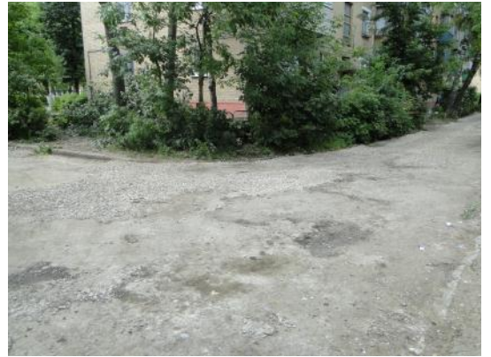
д. 42 Устройство выравнивающего слоя
