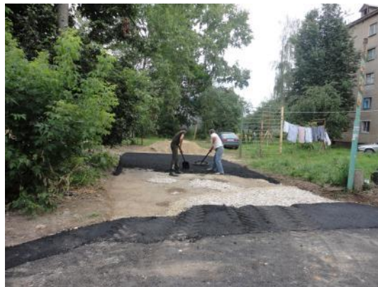
д. 46 Укладка асфальта
