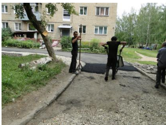
д. 44 Укладка асфальта
