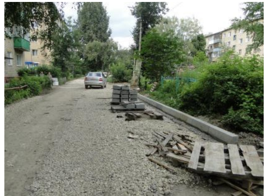
д. 46 Установка бордюрного камня
