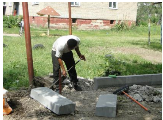
д. 40а Установка бордюрного камня
