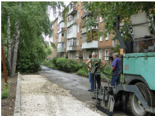
д. 40а Укладка полосы асфальта
