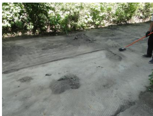
д. 40а Подготовка поверхности
