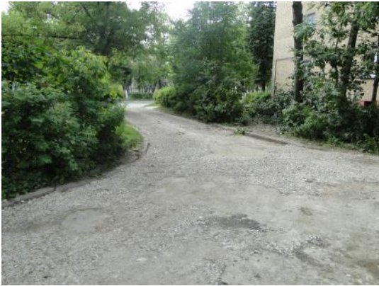
д. 42 Устройство выравнивающего слоя
