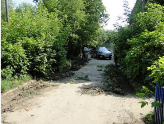
д. 40 Подготовка поверхности
