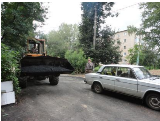
д. 46 Укладка асфальта
