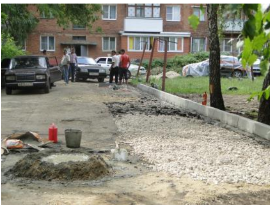
д. 40а Установка бордюрного камня
