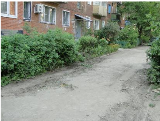
д. 40 Подготовка поверхности
