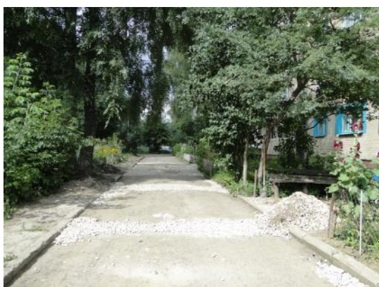
д. 44 Устройство выравнивающего слоя
