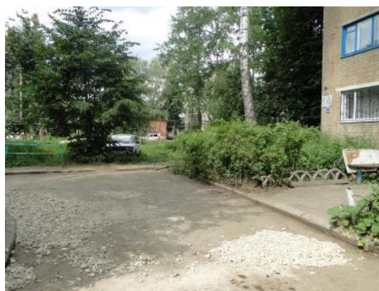
д. 44 Устройство выравнивающего слоя
