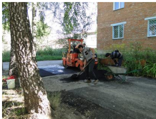
д. 40а Укладка асфальта
