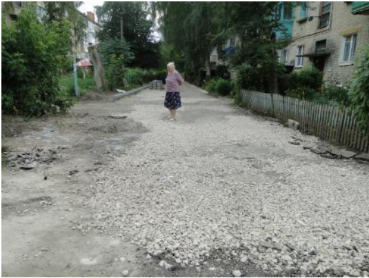
д. 46 Устройство выравнивающего слоя
