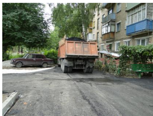
д. 46 Укладка асфальта
