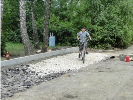
д. 40а Устройство выравнивающего слоя
