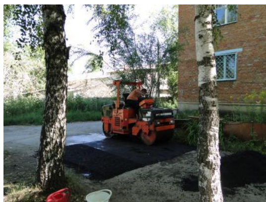
д. 40а Укладка асфальта
