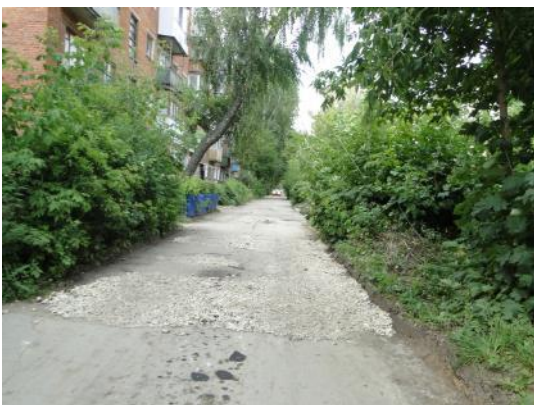
д. 40 Устройство выравнивающего слоя
