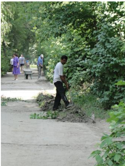
д. 40 Подготовка поверхности
