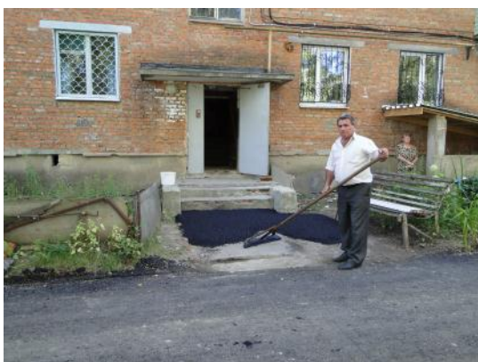
д. 40а Укладка асфальта
