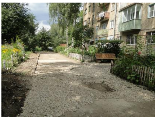
д. 44 Устройство выравнивающего слоя
