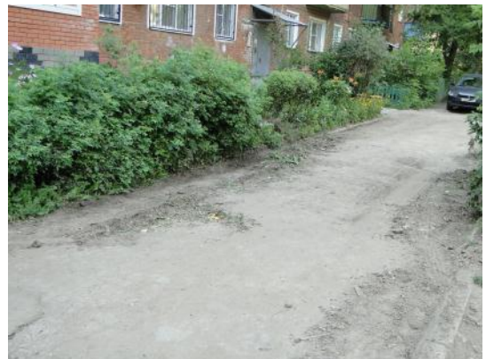
д. 40 Подготовка поверхности
