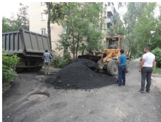
д. 46 Укладка асфальта
