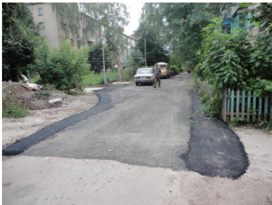
д. 46 Укладка асфальта
