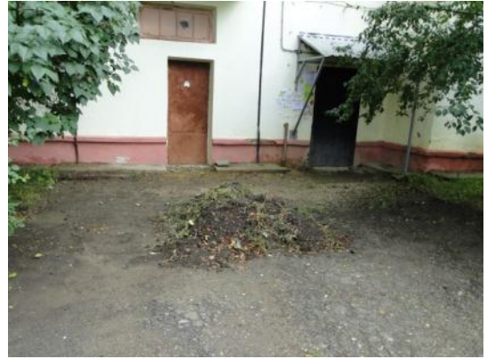
д. 21 Подготовка поверхности
