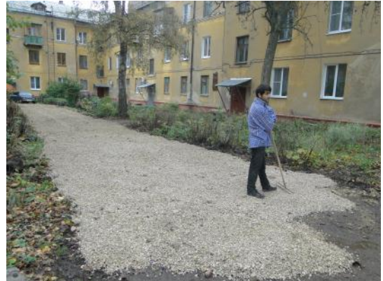
Устройство выравнивающего слоя
