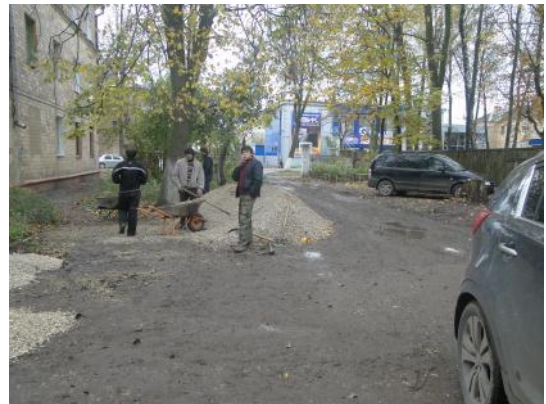
Устройство выравнивающего слоя
