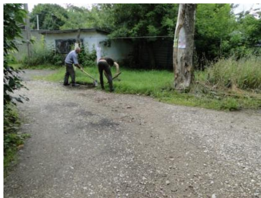
д. 21 Подготовка поверхности
