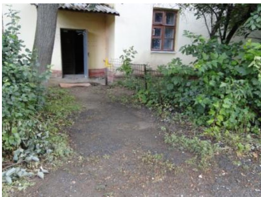
д. 19 До ремонта
