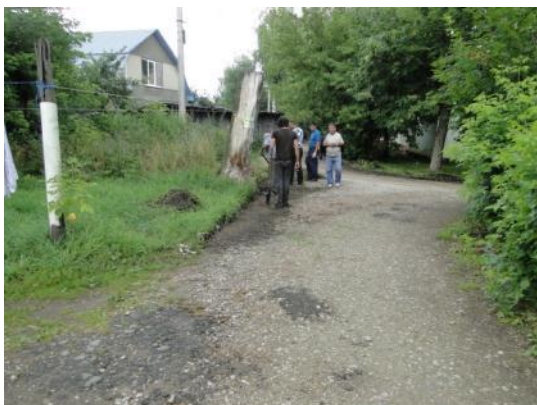
д. 19 Подготовка поверхности
