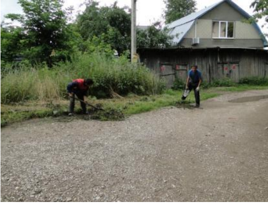
д. 21 Подготовка поверхности
