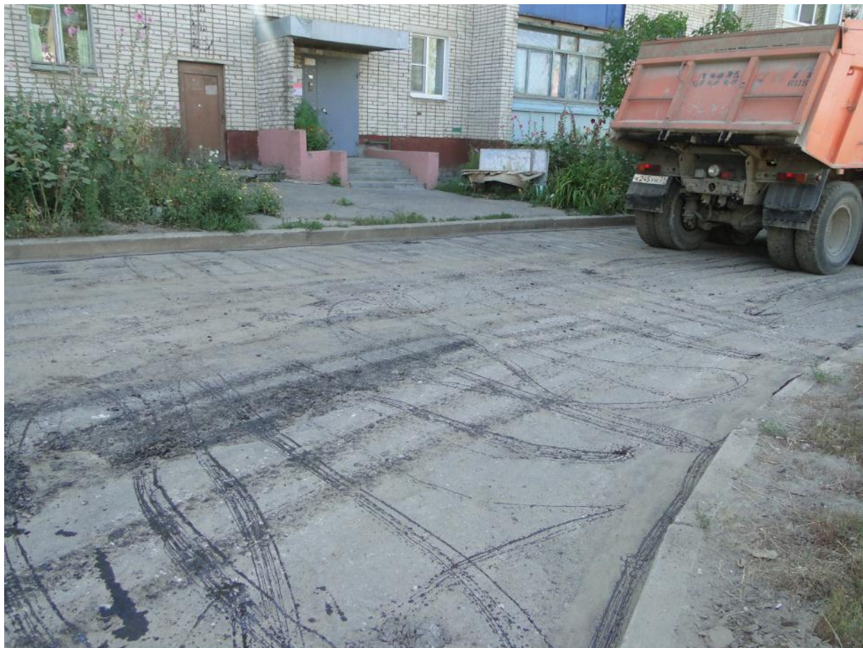
д.8 Укладка асфальта
