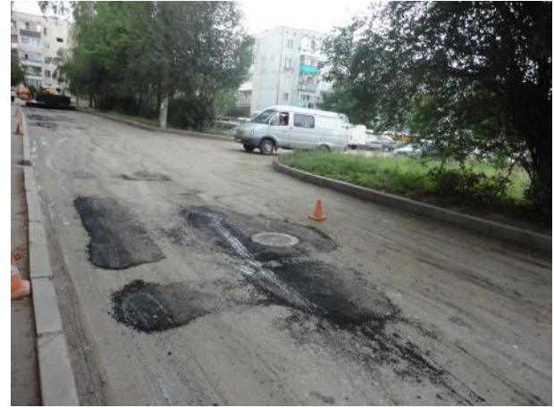
д.4 Подготовка поверхности
