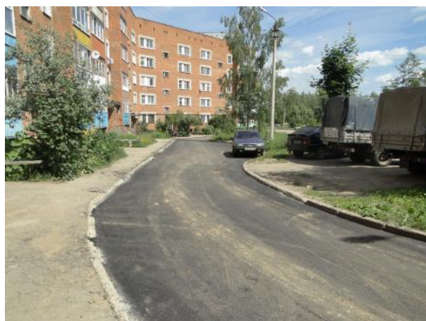
д.14 Укладка асфальта
