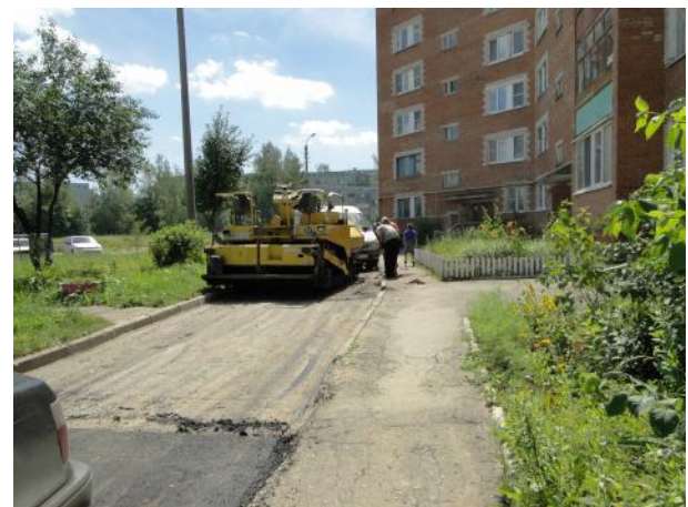
д.14 Укладка асфальта
