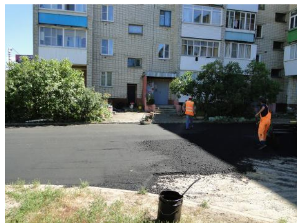
д.8 Укладка асфальта
