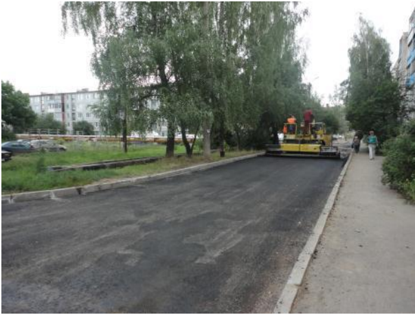
д.4 Укладка асфальта
