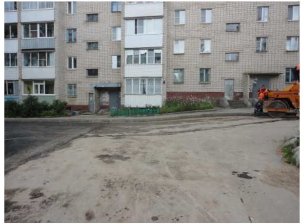
д.4 Укладка асфальта
