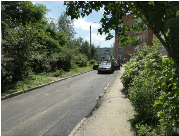
д.14 Укладка асфальта
