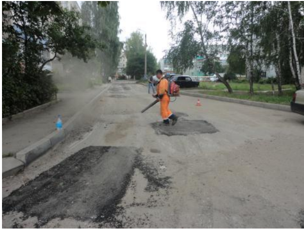
д.4 Подготовка поверхности
