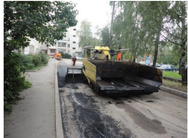
д.4 Укладка асфальта
