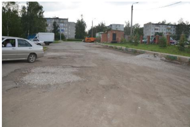
д.8 Подготовка поверхности
