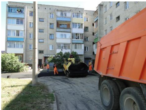
д.8 Укладка асфальта
