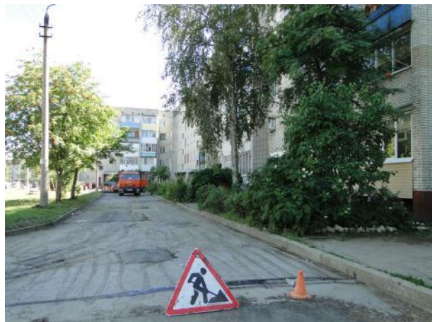
д.8 Укладка асфальта
