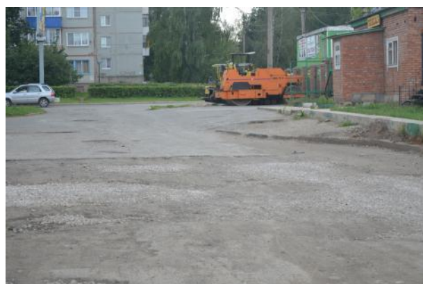
д.8 Подготовка поверхности
