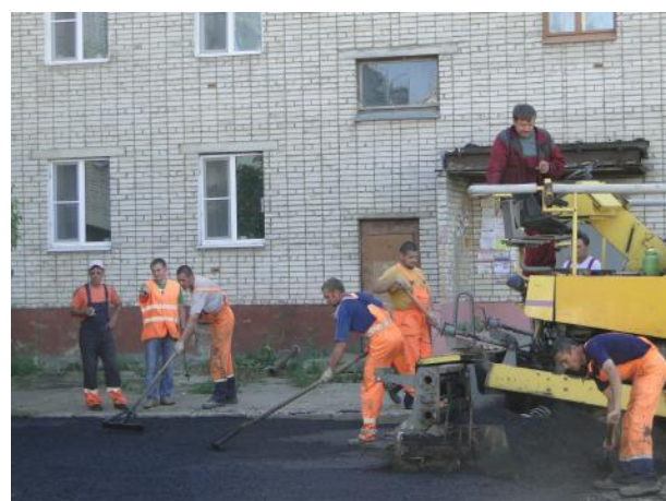
д.8 Укладка асфальта
