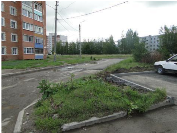
д.14 Подготовка поверхности
