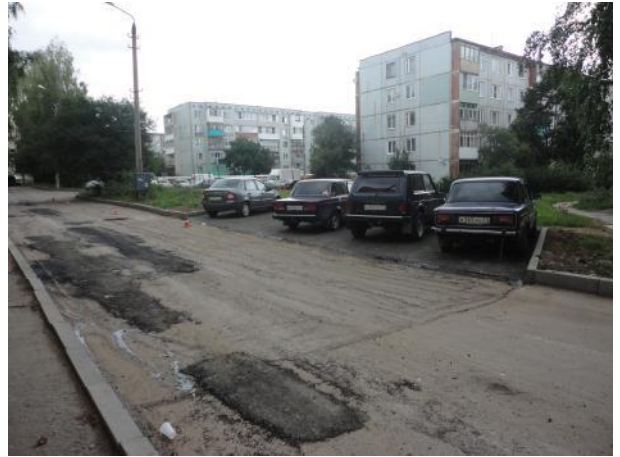
д.4 Подготовка поверхности
