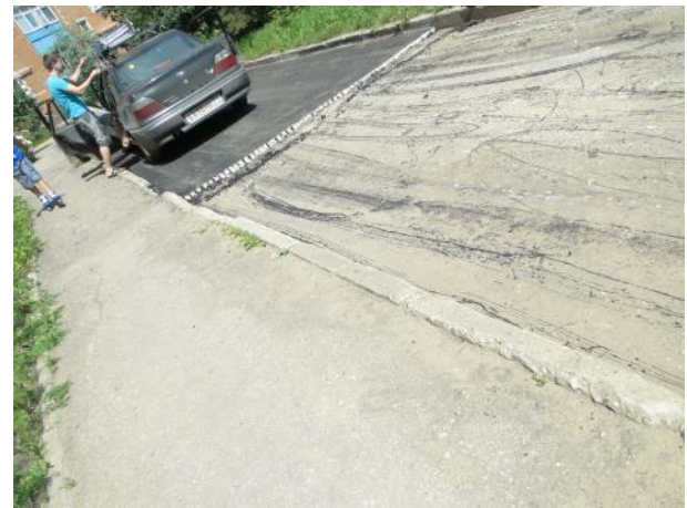
д.14 Укладка асфальта
