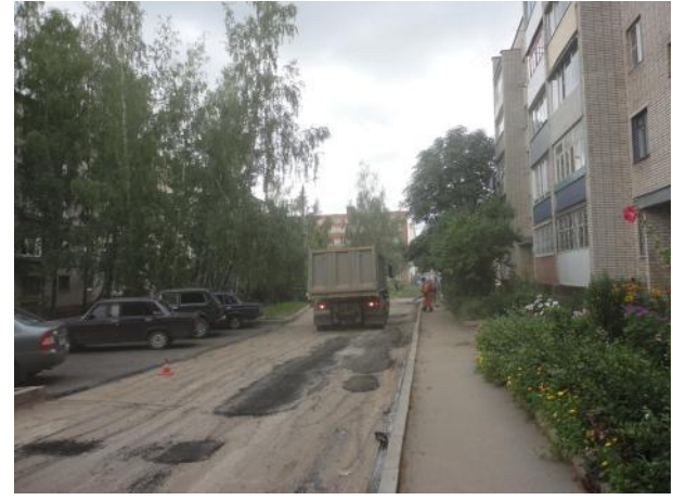
д.4 Подготовка поверхности
