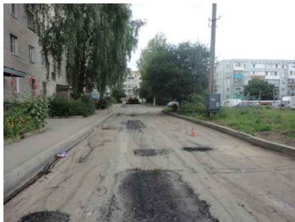
д.4 Подготовка поверхности
