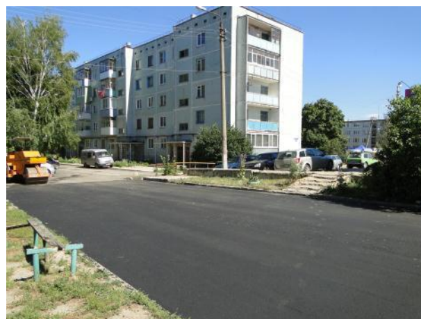
д.8 Укладка асфальта
