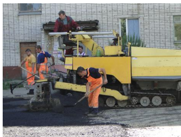
д.8 Укладка асфальта
