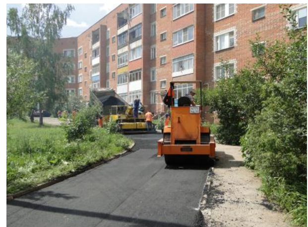
Уплотнение дорожного полотна
