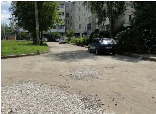
д.8 Подготовка поверхности
