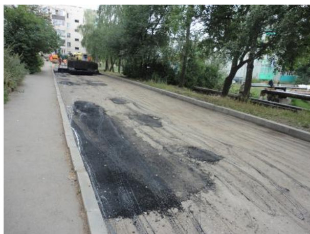
д.4 Подготовка поверхности
