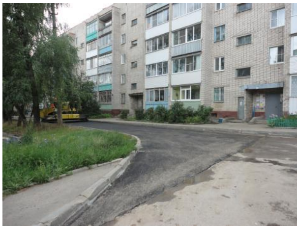
д.4 Укладка асфальта
