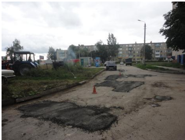
д.4 Подготовка поверхности
