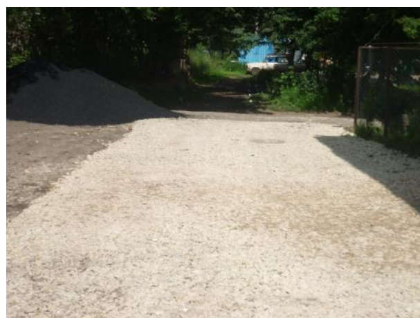
д.13 Подготовка поверхности
