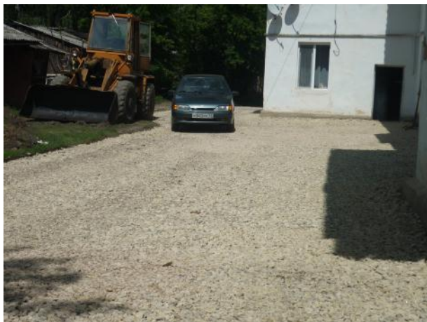
д.13 Подготовка поверхности
