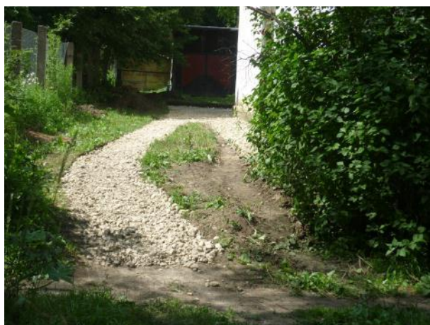
д.13 Подготовка поверхности
