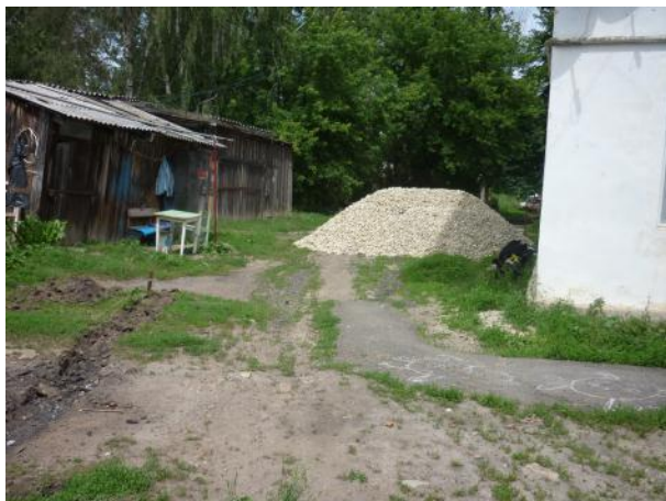
д.13 Начало работ
