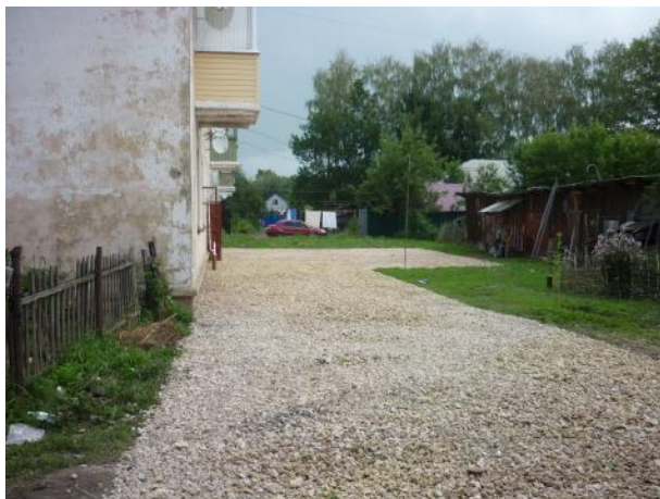
Д.14 подготовка поверхности
