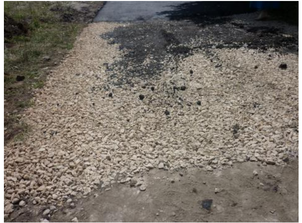
д.8 Подготовка поверхности
