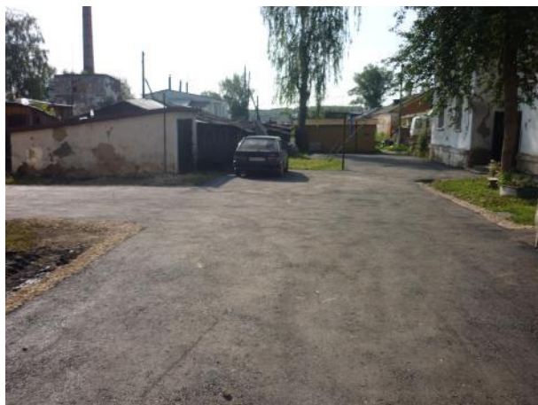
Ул. Лесная д.1 уложенный асфальт
