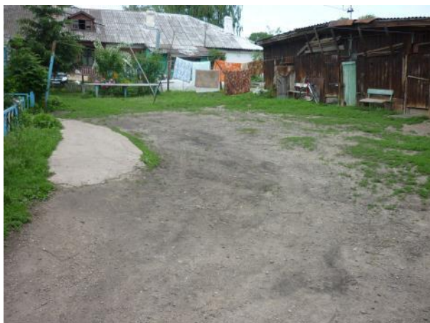
д.9 До ремонта
