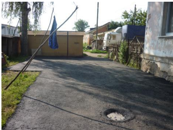
Ул. Лесная д.1 уложенный асфальт
