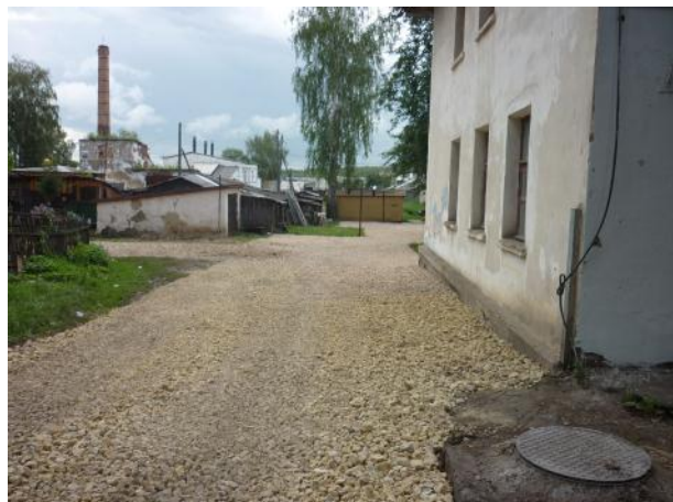
Ул. Лесная д.1 подготовка поверхности
