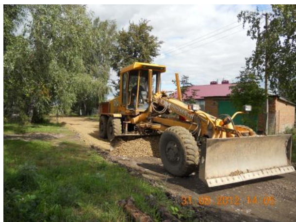
Устройство выравнивающего слоя
