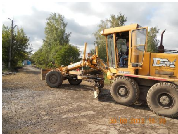
Устройство выравнивающего слоя
