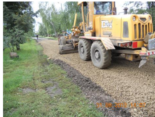
Устройство выравнивающего слоя
