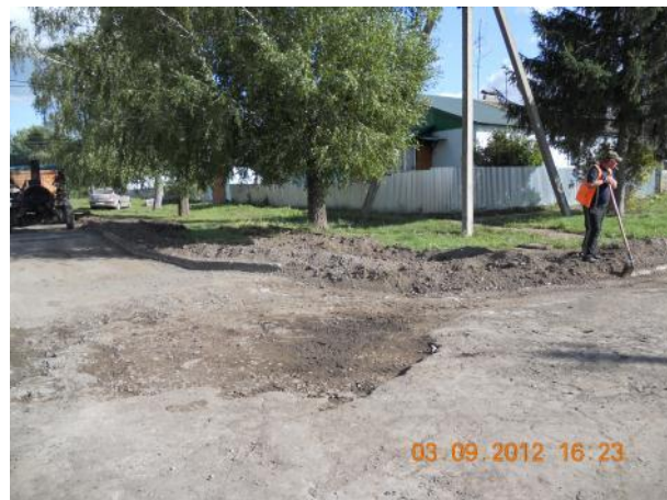
Подготовка поверхности
