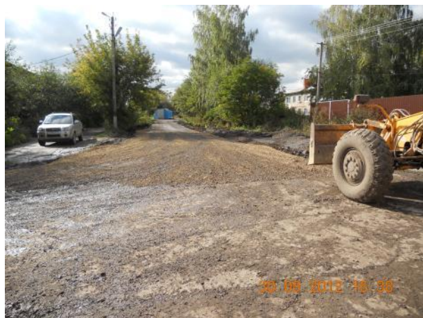
Устройство выравнивающего слоя
